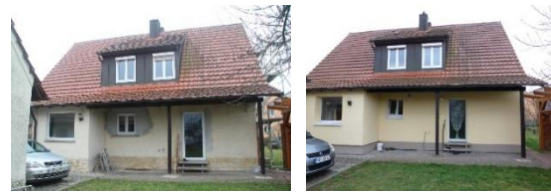
Fotos: vor Sanierung
