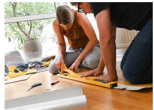
Abbildung 6: Doppelseitiges Klebeband aufbringen.
