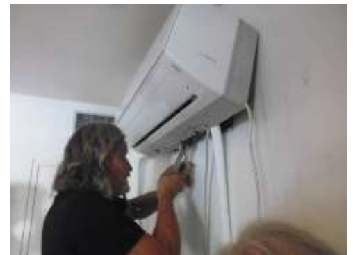
Abbildung 3: Montage des Innenteils
