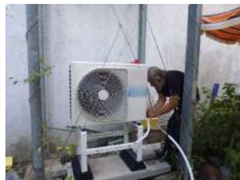
Abbildung 4: Anschluss des Außenteils
