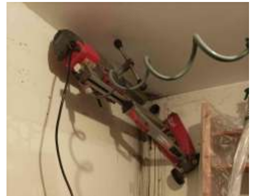
Abbildung 2: Kernlochbohrung in einer Stahlbetonwand
