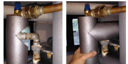
Abbildung 5: So dämmst du einen T-Abzweig perfekt!
