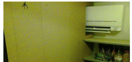
Abbildung 8: Splitgeräte saugen die Luft in der Regel unter der Decke an und blasen sie nach unten aus.
