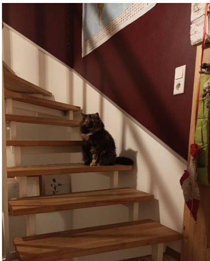
Abbildung 11: Die offenen Treppenstufen im Treppenhaus zwischen EG und OG werden durch die dazwischen aufsteigende Luft erwärmt.
