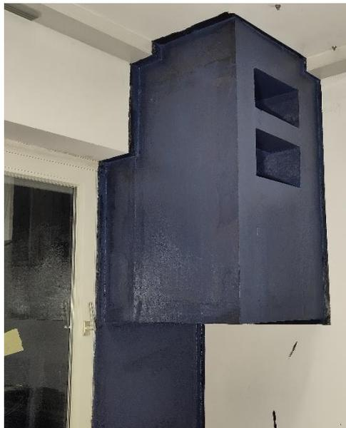
Abbildung 25: Vollflächig abgedichteter Luftkanal
