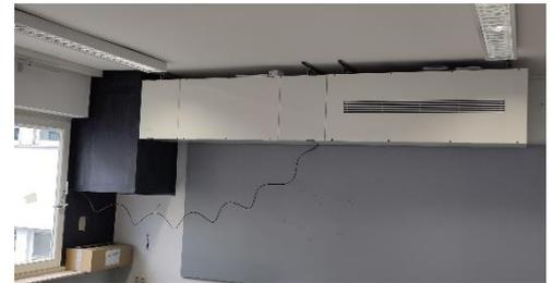
Abbildung 3: fertig montiertes Lüftungsgerät vor dem Fenster
