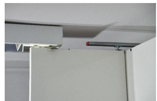
Abbildung 41: Funktionskontrolle der Wartungsklappen – Ein Öffnen ist noch gerade möglich
