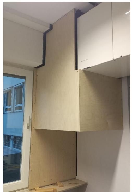
Abbildung 44: fertig verkleideter Luftkanal
