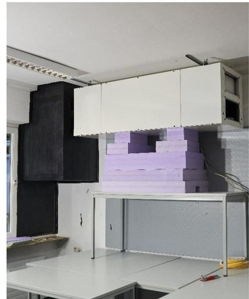
Abbildung 26: Aufgebocktes Lüftungsgerät
