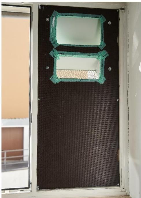
Abbildung 11: Im Fensterrahmen befestigte Siebdruckplatte mit Luftdurchlass.
