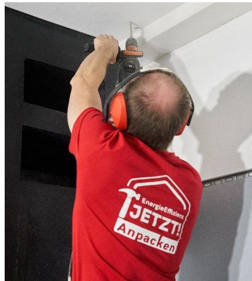
Abbildung 30: Bohren der Löcher für das Anschrauben der Montageschienen
