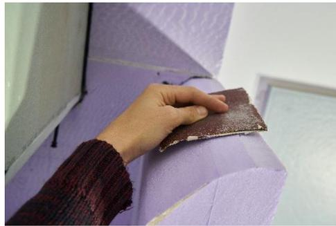
Abbildung 28: Schleifen der Schnittkante
