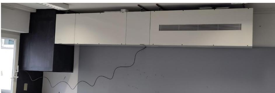
Abbildung 40: Fertig eingebautes Lüftungsgerät mit Schalldämpfer
