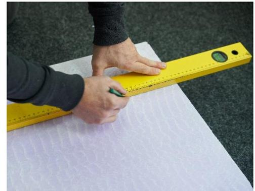
Abbildung 13: Anzeichnen der Dämmplatten
