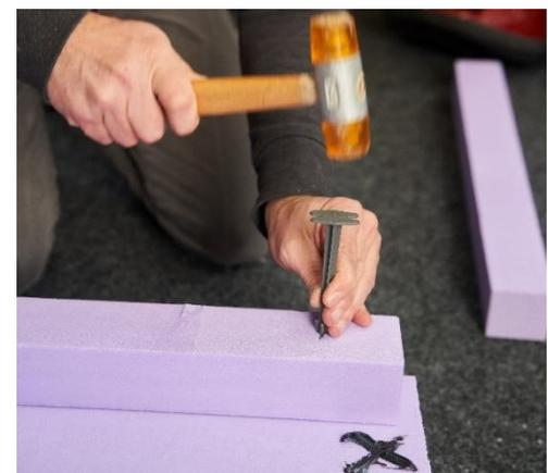
Abbildung 17: Einschlagen der Einschlag-Dämmstoffdübel
