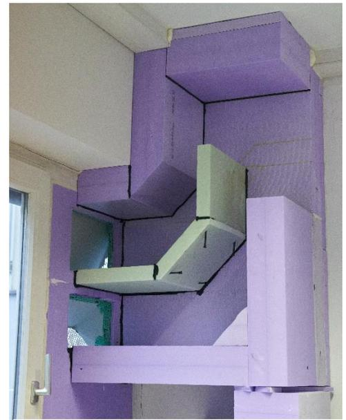
Abbildung 23: Aufbau des fast fertiggestellten Luftkanals
