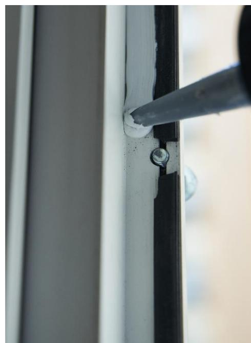
Abbildung 9: Ziehen der Kleberaupe neben der alten Dichtung
