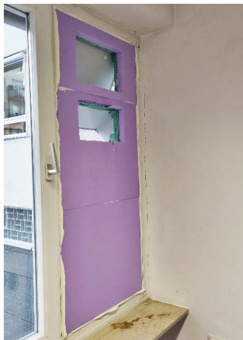
Abbildung 12: Siebdruckplatte mit aufgeklebter Dämmplatte
