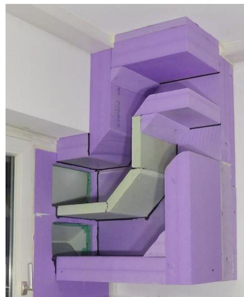
Abbildung 4: Innenansicht des Luftkanals vom Lüftungsgerät nach außen
