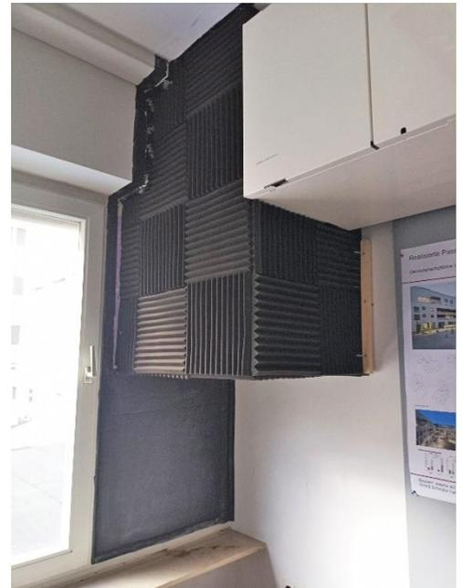
Abbildung 42: Mit Akustik-Schaumstoffplatten verkleideter Luftkanal
