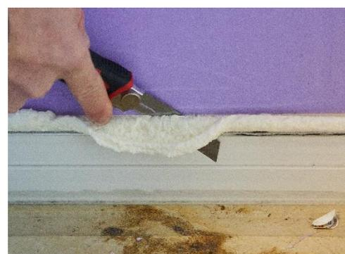
Abbildung 10: Entfernen des überflüssigen PU-Schaums
