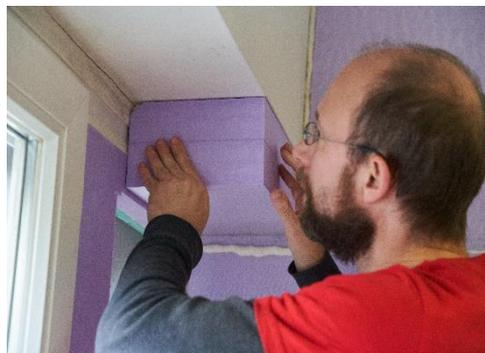
Abbildung 21: Anbringen der Dämmplatten
