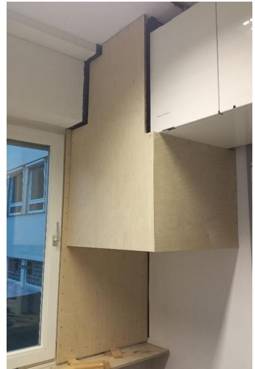
Abbildung 45: fertig verkleideter Luftkanal
