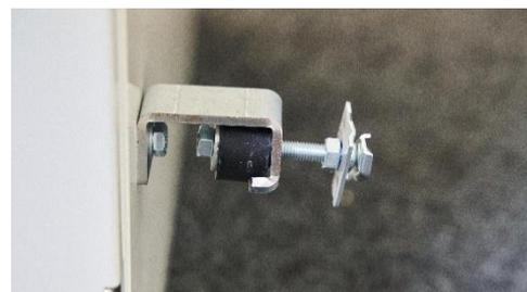
Abbildung 32: Mechanismus des Lüftungsgeräts zur Befestigung an Montageschienen
