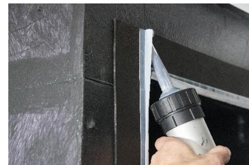
Abbildung 33: Luftdichte Verklebung des Komprimbandes
