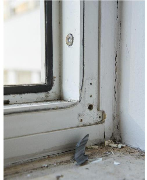
Abbildung 6: Fensterrahmen mit entfernten Beschlägen
