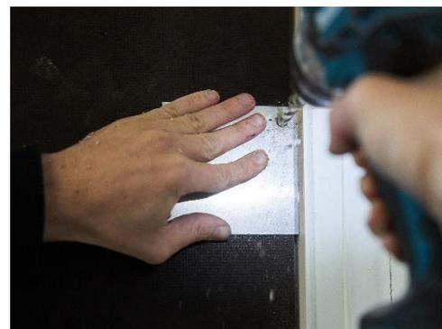
Abbildung 8: Vorbohren der Schraublöcher zur Befestigung der Siebdruckplatte am Fensterrahmen
