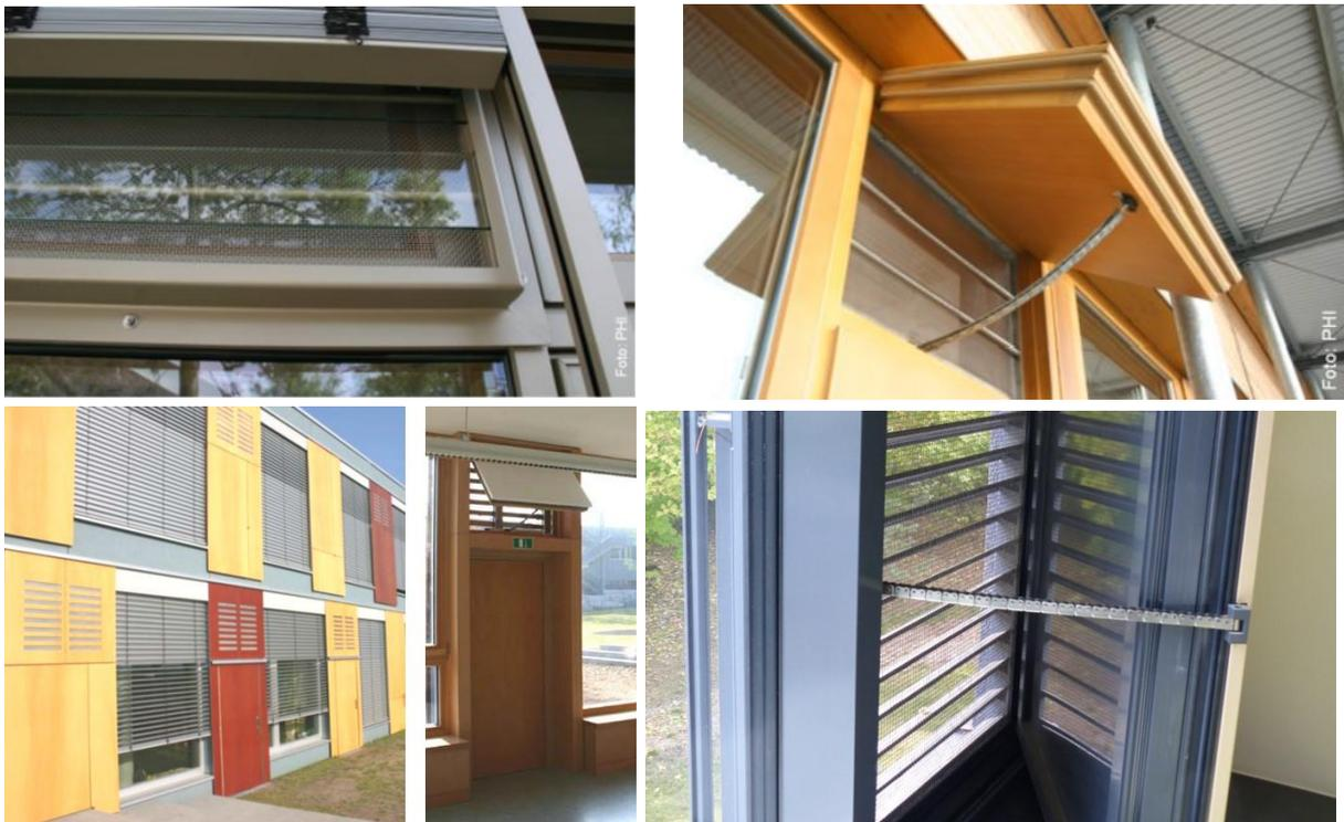
**Abbildung 6:** Beispiele für Nachtlüftungsklappen mit Schutzmaßnahmen:
