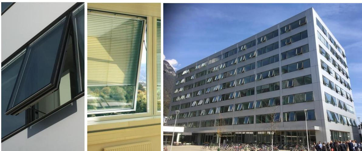
**Abbildung 7:** Modernisiertes Bauingenieur-Gebäude der Universität Innsbruck mit motorisch betriebenen Senkklass-Fenstern für die Sommerlüftung (Fotos: PHI).
