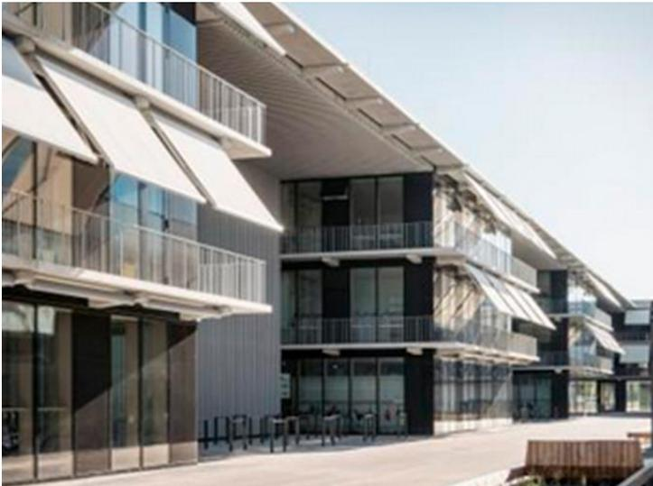
**Abbildung 1: Kombination aus feststehendem und beweglichem Sonnenschutz; Baumschlager Hutter Partners**
