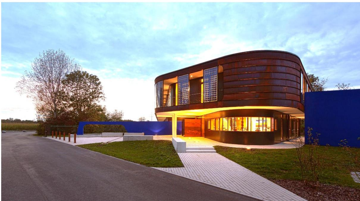
**Abbildung 7:** Ostseite mit umlaufendem Balkon; Eingang rückversetzt, eine Stahlbetonwand führt als Leitwand in das Gebäude, der äußere und innere Bereich der Leitwand sind thermisch getrennt; Photovoltaikmodule befinden sich auf dem Dach und repräsentativ im Bereich des Balkons.
