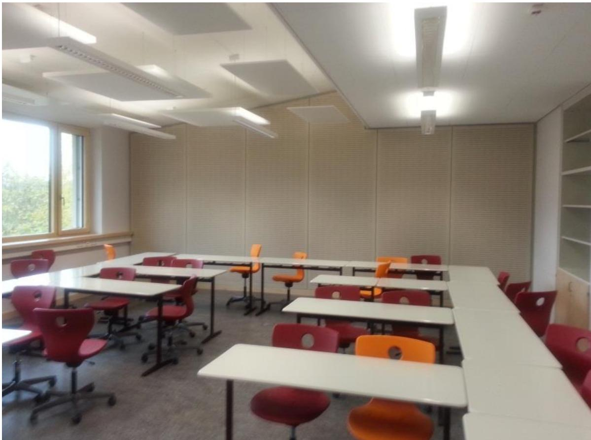
**Abbildung 5:** Klassenraum Bertha-von Suttner Schule Mörfelden-Walldorf: thermische Speichermasse Betondecke weiß gestrichen, ist mit abgehängten Akustiksegeln zugänglich und trägt zur Pufferung von Temperaturspitzen bei. Als Kompensation wurden Akustikpaneele an der Rückwand angebracht. Auf der rechten Seite ist die Abkofferung für Lüftung zu sehen.
