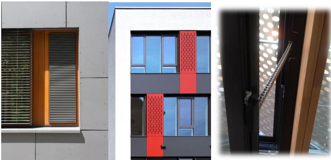
**Abbildung 4:** verschiedene Ausführungen von Nachtlüftungsklappen
