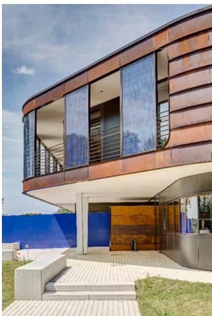
Der Balkon bewirkt eine passive Verschattung und hat dadurch einen positiven Effekt auf das Sommerklima im Innenraum. Zudem ist die Möglichkeit gegeben, über die Öffnungsflügel der Laterne und die Oberlichter der normalen Fenster für eine zusätzliche Belüftung zu sorgen.
