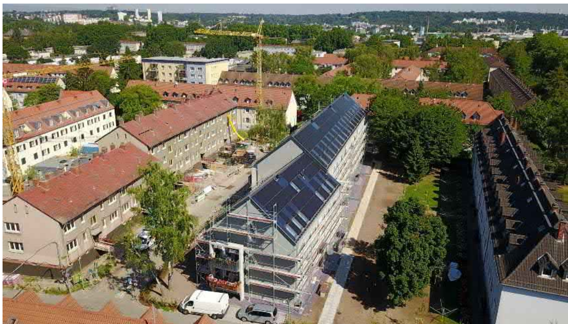
Abbildung 2: Projekt in Frankfurt-Riederwald während der Bauphase
