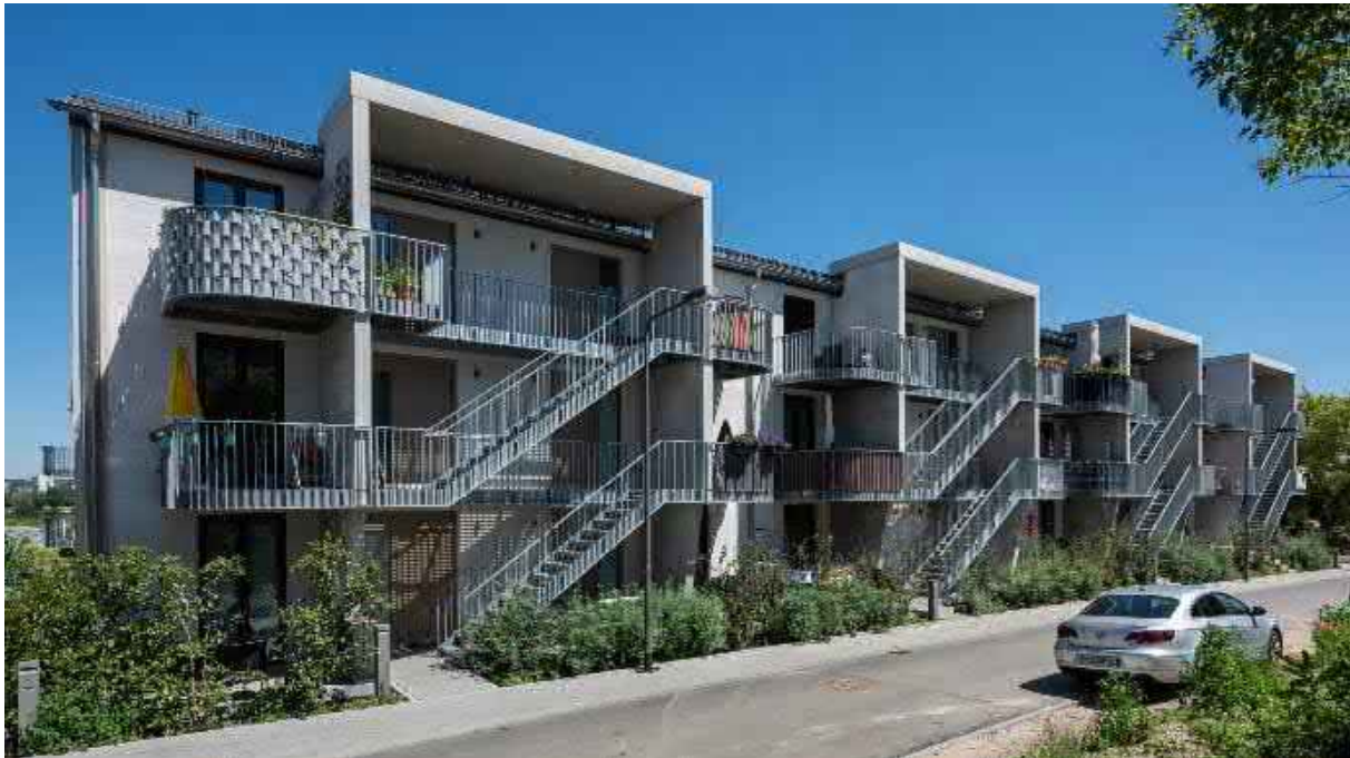
Abbildung 1: Außenansicht der Gebäude Im Wiener in Frankfurt-Oberrad
