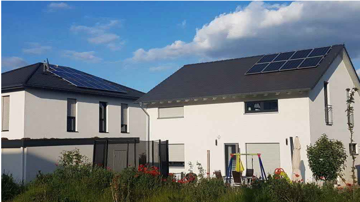
Abbildung 3: Passivhaus-Neubauten mit PV-Anlage. In diesem Beispiel wird die verfügbare Dachfläche nicht vollständig ausgenutzt. Das ist einzelwirtschaftlich sinnvoll, wenn die Einspeisung sich nicht lohnt. Global gedacht ist diese Lösung jedoch fragwürdig. Foto: PHI
