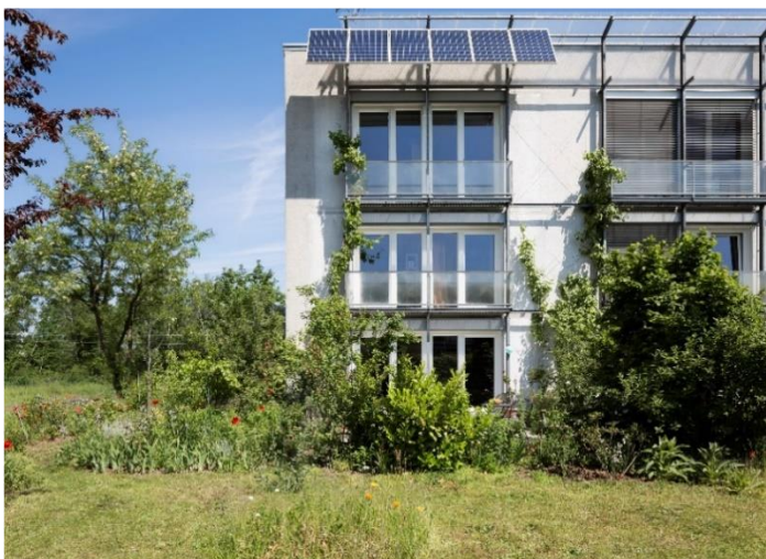
Der Physiker Wolfgang Feist wohnt mit seiner Familie bis heute im weltweit ersten Passivhaus in Darmstadt. Er rüstete eine PV-Anlage und ein Klima-Split-Gerät nach, mit dem drei Etagen komfortabel geheizt werden. ID 0195 © Peter Cook
