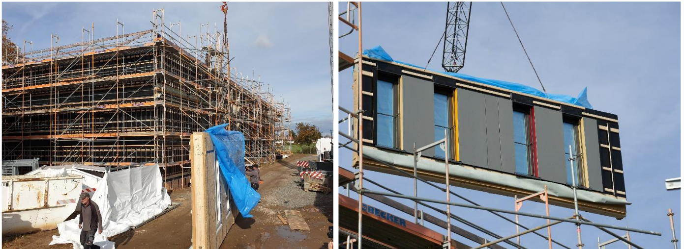
Energetische Sanierung und Erweiterung eines Schulgebäudes. Dabei wurden vorgefertigte Fassadenelemente verwendet, die unter anderem bereits die Passivhaus-Dämmung sowie die Passivhaus-Fenster enthielten. Die über 70 Elemente konnten im November 2025 innerhalb von wenigen Tagen an das Schulgebäude angebracht werden. © Passivhaus Institut
