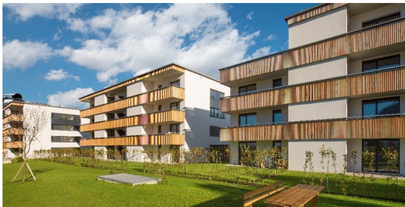
Sozialer Wohnungsbau des österreichischen Wohnbauunternehmens Neue Heimat Tirol in Kufstein. Die NHT baut ausschließlich im Passivhaus-Standard. © Neue Heimat Tirol
