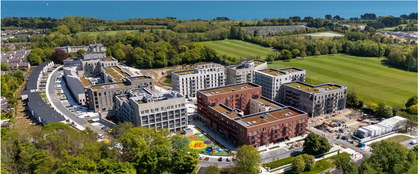
Der Passivhaus-Standard wird zunehmend auch im sozialen Wohnungsbau umgesetzt. Im Bild: Projekt Shanganagh Castle in Dublin mit fast 600 Wohnungen und einigen Einfamilienhäusern. © Land Development Agency
