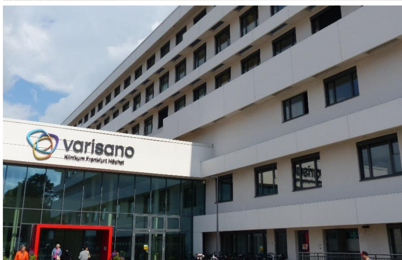
Das Klinikum Frankfurt Höchst zog Anfang 2023 in seinen Neubau: das weltweit erste zertifizierte Passivhaus-Krankenhaus. Das Passivhaus Institut erstellte zuvor eine Grundlagenstudie, die auf sehr großes Interesse stößt. ID 7142 © Klinikum Frankfurt Höchst (o.); Passivhaus Institut (u.)
