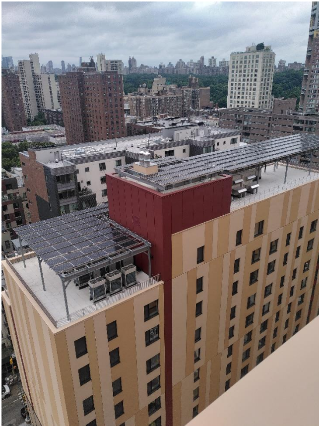
Eines von vielen Passivhaus-Projekten in den USA: Im New Yorker Stadtteil Harlem entstand mit Sendero Verde ein Komplex mit über 650 bezahlbaren und komfortablen Wohnungen. ID 6369 © Passivhaus Institut
