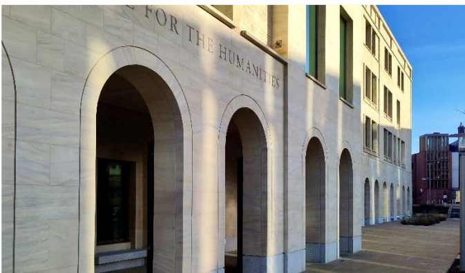
Die britische Universität Oxford realisierte ihr neues Zentrum für Geisteswissenschaften im Passivhaus-Standard. Das Zentrum umfasst u.a. sieben Fakultäten, Konzertsaal, Theater sowie ein multifunktionales Atrium (oben). ID 8130 © Will South, Etude
