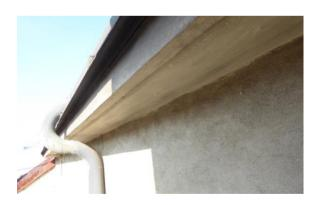
Das Dach besteht bis zur obersten Geschossdecke aus Beton. Die Dämmung erfolgt demnach auf der Außenseite des Betons. Hierfür muss die Dachdeckung vermutlich vollständig erneuert werden.
