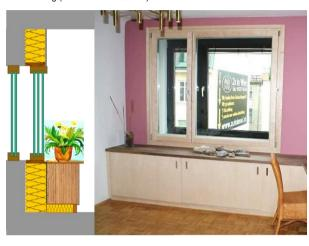
Im Zuge des 2. Modernisierungsschrittes wurden die Bestand-Fenster durch ein zusätzliches Fenster (innen) wärmetechnisch verbessert.
