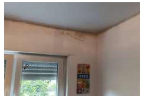
Abbildung 6: Schimmel an der Wand, entstanden durch eine Kombination von schlechtem Wärmeschutz und zu wenig Lüften. Dazu muss es nicht kommen, mit oder ohne Teilbeheizung!
