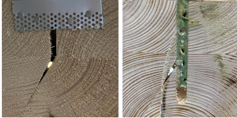
Abbildung 32: Aufnahmen der sichtbaren Leckage in dem Prüfkörper 4 (rechts 7/70 mm abknickend) unter Anwendung der Methode 1 (Injektionskanal)
