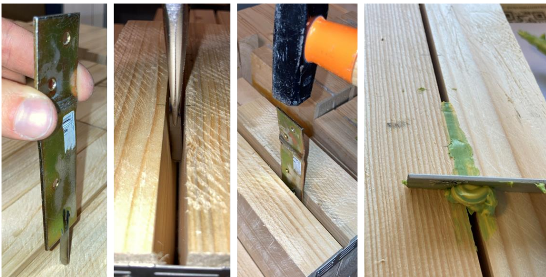
Abbildung 23: Die beschriebenen Arbeitsschritte zur Anwendung von Methode 3 (Injektion mit Klinge) von links nach rechts
