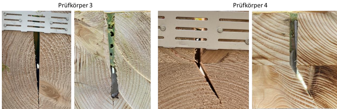
Abbildung 34: Aufnahmen der sichtbaren Leckagen in dem Prüfkörper 3 (links 10/120 mm Riss) und 4 (rechts 7/70 mm abknickender Riss) unter Anwendung der Methode 3 (Injektion mit Klinge)
