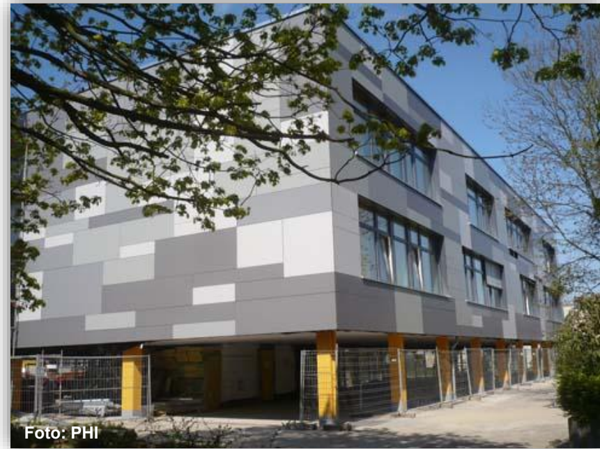
Passivhaus Altbauanierung Baesweiler (ID 1804)
