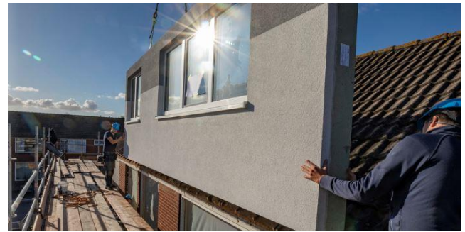
Serielle Sanierung von 194 Reihenhäusern in der niederländischen Provinz Zeeland. Die Installation von vorgefertigten Elementen spart Bauzeit und Baukosten. © Bouwbedrijf Joziassse
