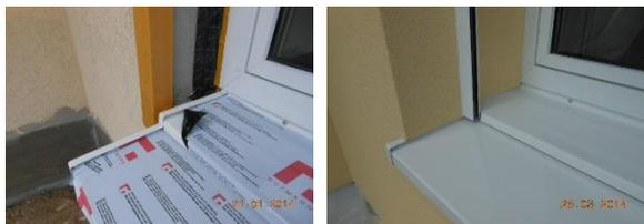
Abb.1: Fassadendämmung gemäß EnerPHit-Sanierungsplan: Der spätere Einbau eines Passivhaus-Fensters mit optimaler Lage in der Dämmebene wird schon vorbereitet (zweigeteilte Fensterbank, Holzrahmen zur späteren Montage des Passivhaus-Fensters). © Passivhaus Institut
