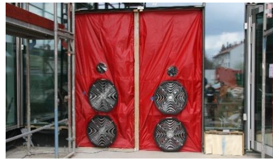
Luftdichtheitsmessung bei einem Hallenbad.
