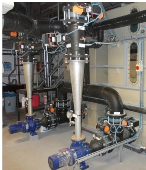
Fig. 18 : Pompes de circulation dans le circuit d'eau du bassin sans (à gauche) et avec (à droite) un diffuseur en aval (Photos : à gauche PHI ; à droite INCO)
