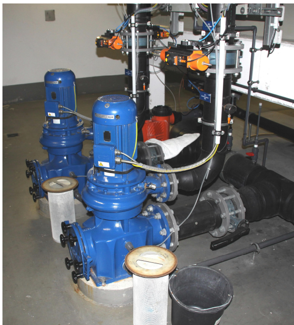
Fig. 18 : Pompes de circulation dans le circuit d'eau du bassin sans (à gauche) et avec (à droite) un diffuseur en aval (Photos : à gauche PHI ; à droite INCO)
