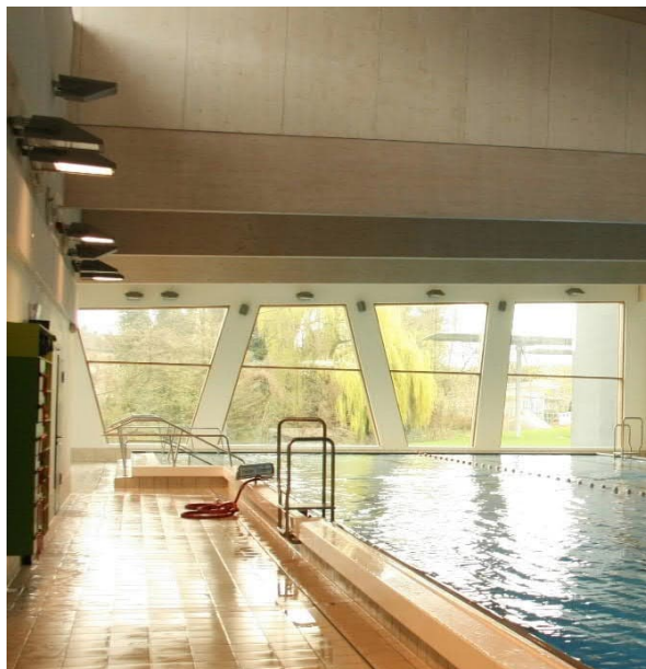
Illustration 7 : Piscine Lippe, une tête de bassin relevée permet de réaliser un parapet pour la façade MR sans gêner la visibilité des nageurs vers l'extérieur.
