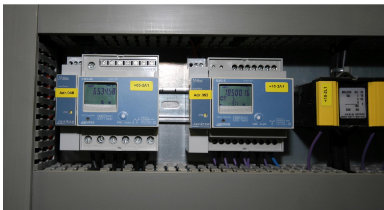
Fig. 32 Compteur électrique dans une armoire GTC
