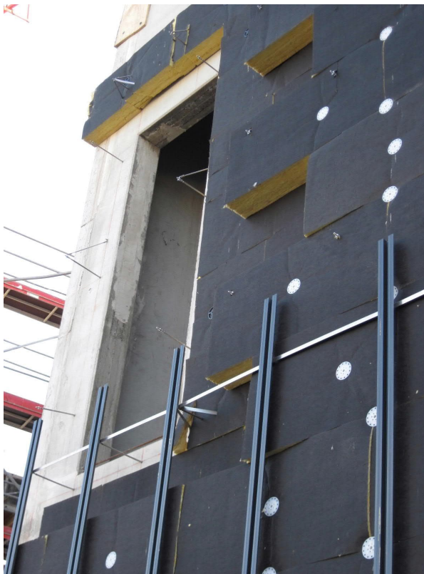
Fig. 6 Exemple de ponts thermiques réduits : A gauche : Consols de façade pour le mur-rideau sans ponts thermiques A droite : Acrotère en construction en bois
