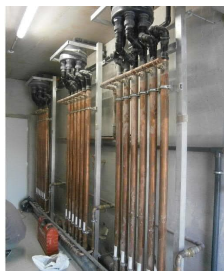
Fig. 29 : à gauche : Exemple de raccordement de tubes collecteurs d'échangeurs de chaleur pour la récupération de la chaleur des eaux usées des douches ; source : Q-Blue (traduction PHI) A droite : Récupération de chaleur de l'eau de douche MulitVert à la piscine couverte de Mons en Baroeul (France) ; source : Gaïa Green
