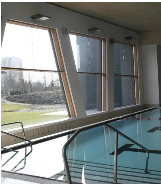
Illustration 7 : Piscine Lippe, une tête de bassin relevée permet de réaliser un parapet pour la façade MR sans gêner la visibilité des nageurs vers l'extérieur.
