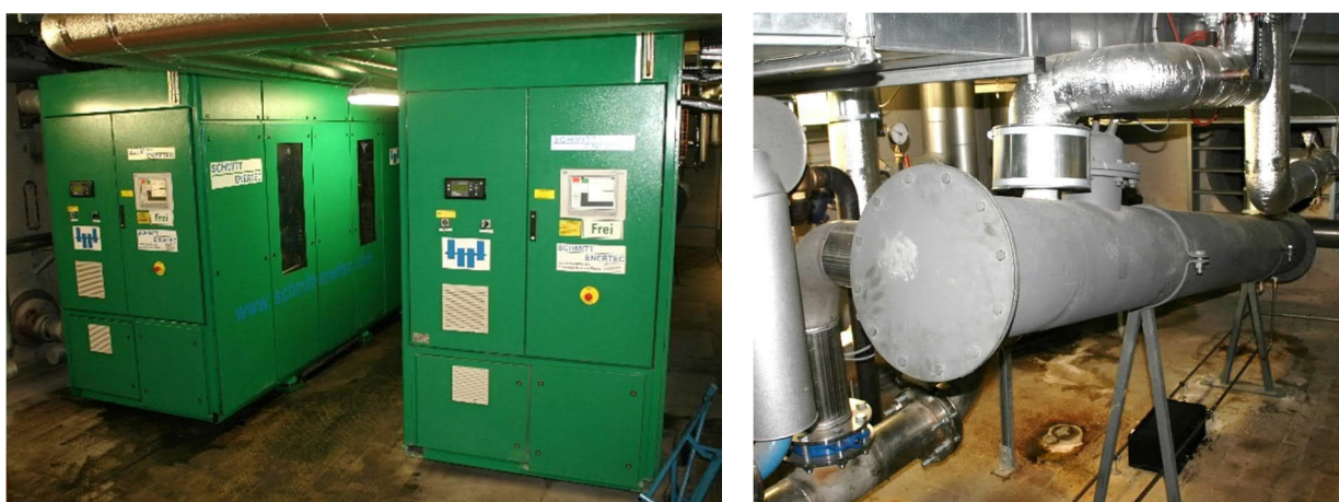
Fig. 31 : Lippe-Bad Lünen : le gaz naturel et la centrale de cogénération au biogaz (à gauche) et l'échangeur de chaleur des gaz d'échappement d'une des centrales de cogénération (à droite) permet d'utiliser la chaleur résiduelle "gratuite".
