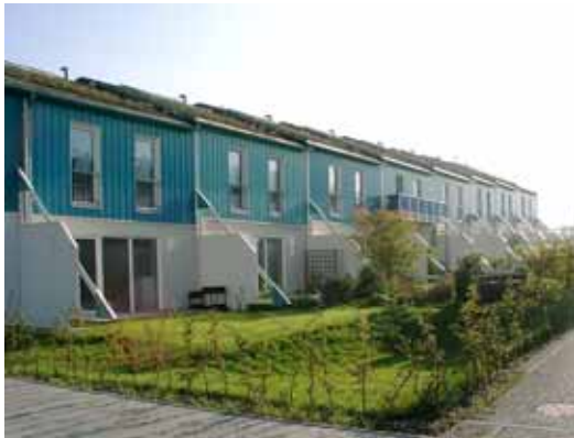
Abbildung 75: Eine von vier Reihenhausszeilen der Passivhaus-siedlung in Hannover
