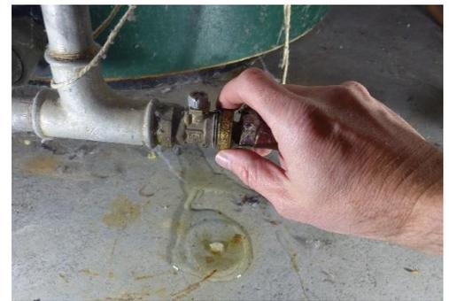
Abbildung 7: Heizung und Trinkwassernetz zum Nachfüllen verbinden
