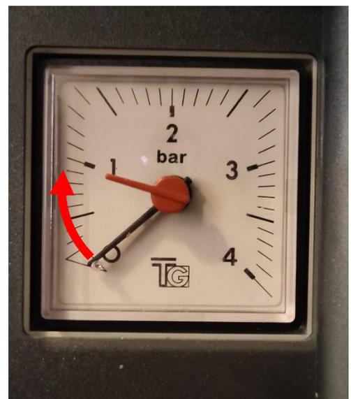
Abbildung 6: Druck kontrollieren und gegebenenfalls Heizungswasser nachfüllen.
