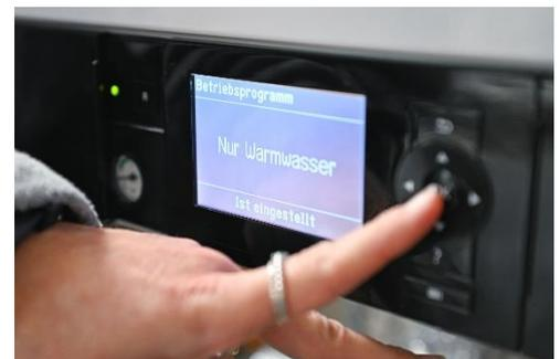
Abbildung 11: Sommerbetrieb einstellen: Nur Warmwasser
