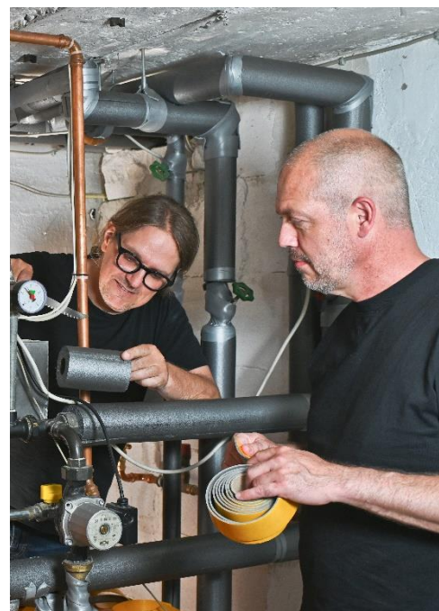
Abbildung 1: Sparen durch Leitungsämmung. So geht's: DIY-Anleitung „Warme Rohre dämmen“
