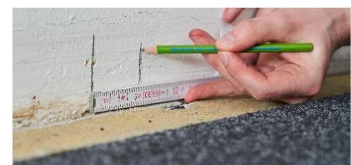
Abbildung 12: Markieren der Position der Verbundträger
