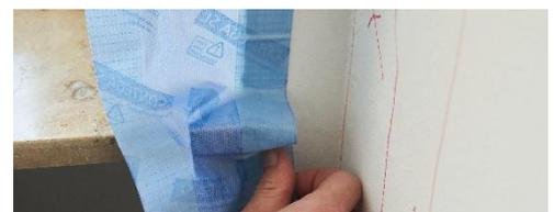
Abbildung 20: Verlauf des Klebebands um eine Fensterbank
