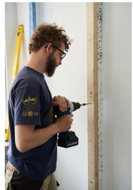
Abbildung 28: Ausrichten der Träger (links), Bohren der Löcher (mittig) und Einschrauben der Fensterrahmenschrauben
