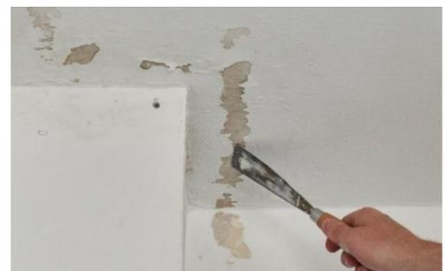
Abbildung 21: Entfernen von nicht tragfähigem bzw. nicht klebefähigem Untergrund
