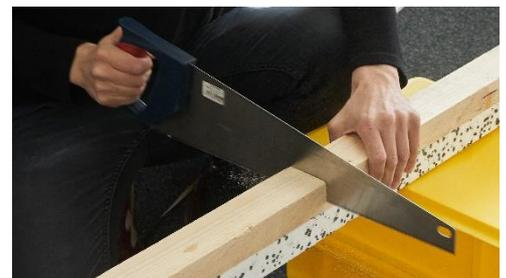
Abbildung 23: Ablängen des Holzquerschnitts des Verbundträgers mit einem Fuchsschwanz
