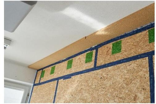
Abbildung 44: Wand mit fertiggestellter Flankendämmung
