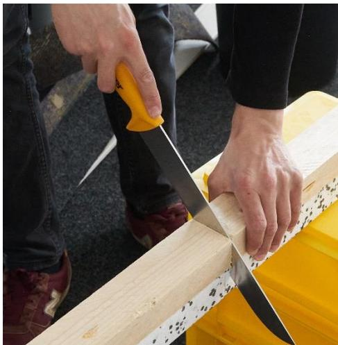
Abbildung 24: Ablängen des Dämmteils der Verbundträger mit einem Dämmstoffmesser
