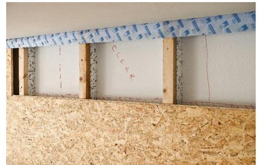
Abbildung 30: Ansicht der Gefache vor dem Anbringen der obersten Plattenreihe
