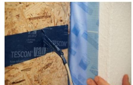
Abbildung 35: Luftdichte Kabeldurchführung 2/2
