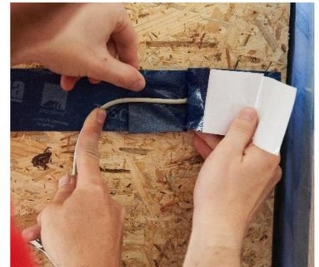
Abbildung 34: Luftdichte Kabeldurchführung 1/2
