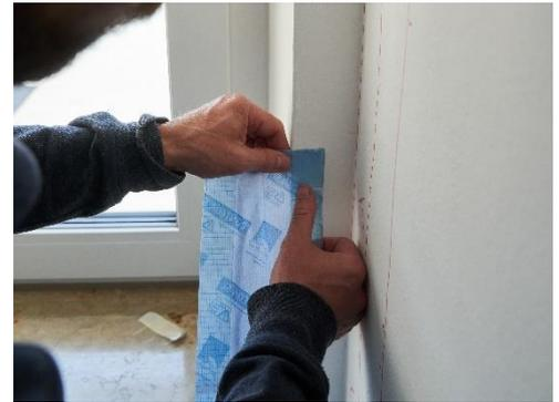
Abbildung 17: Anbringen des umlaufenden Luftdichtheitsklebebandes
