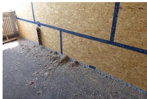
Abbildung 40: Ansicht der gedämmten Wand mit überschüssiger Zellulosedämmung und luftdicht eingebauter Steckdosenleiste
