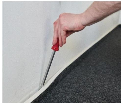
Abbildung 4: Entfernen der Fußleiste
