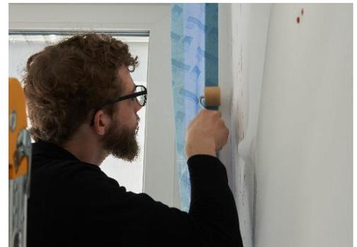
Abbildung 18: Andrücken des Klebebandes mit Hilfe einer Andrückrolle
