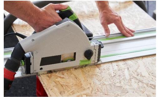
Abbildung 29: Zurechtsägen der OSB-Platten
