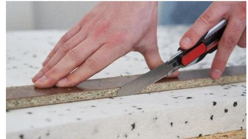
Abbildung 13: (mühsames) Schneiden der EPS-Platten mit einem Cuttermesser
