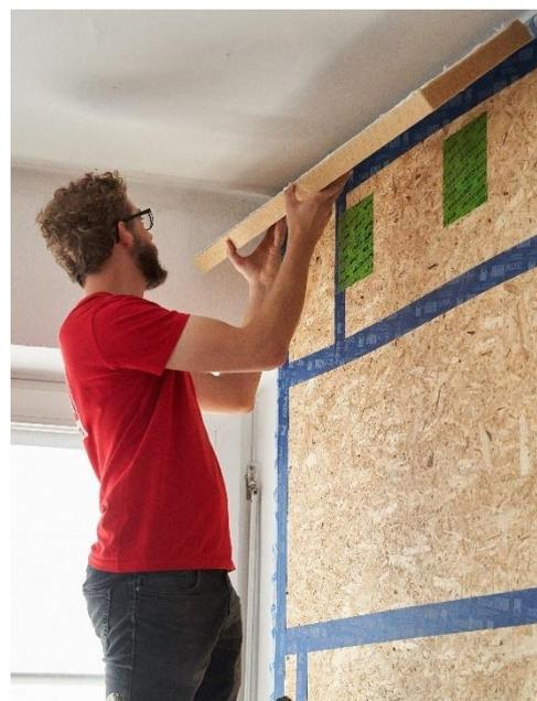
Abbildung 43: Ankleben der Flankendämmung (hier als ganze Platten statt in Keilform)
