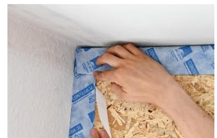
Abbildung 36: Ankleben des umlaufenden Luftdichtheitsklebebands und die Ausführung im Eckbereich
