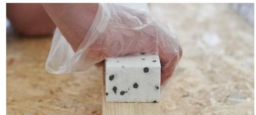
Abbildung 16: Verklebung EPS-Profile auf die Kanthölzer – der Verbundträger entsteht.
