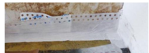
Abbildung 10: Luftdichte Verklebung zwischen Wand und Boden
