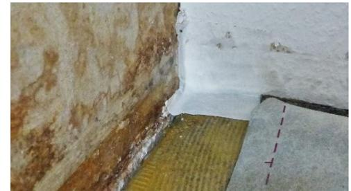
Abbildung 9: Eckverbindung des luftdichten Anschlusses
