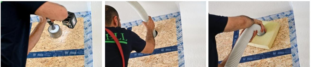
Abbildung 38: Bohren des Einblasloches (links), Einblasen der Zellulosedämmung (mittig & rechts)
