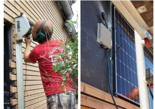
Abbildung 8: Fassadenverkleidung absägen; Wechselrichter und Modul montieren
