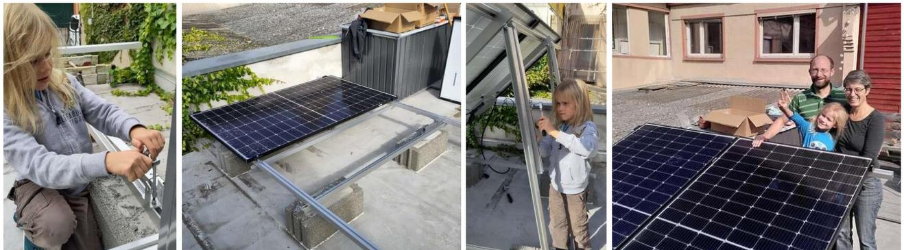
Abbildung 12: Anschrauben der Halterung für die Teleskopstütze; 1. Modul montiert; Justieren der Teleskopstütze; fertig
