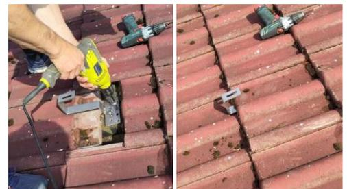
Abbildung 13: Anschrauben der Dachmontagewinkel; wieder verschlossenes Dach
