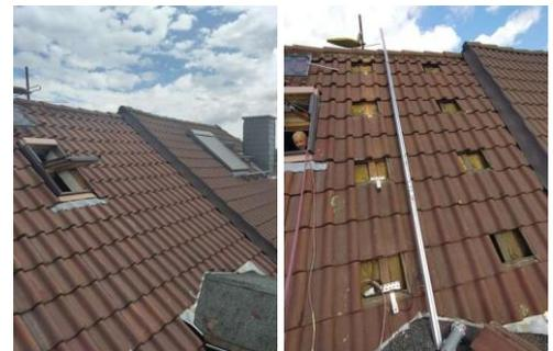
Abbildung 18: Das Dach vorher und zum Anschrauben der Dach-Montagewinkel geöffnet.
