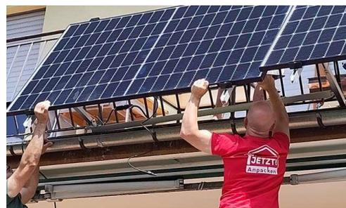
Abbildung 5: Einhängen & ausrichten
