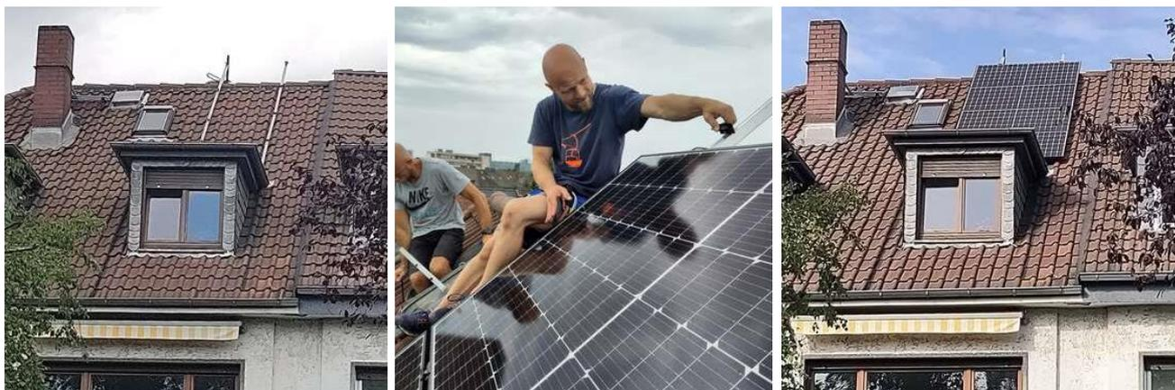
Abbildung 20: Nach dem Anschrauben der Tragprofile; Festklebmen des letzten Moduls; Fertig!
