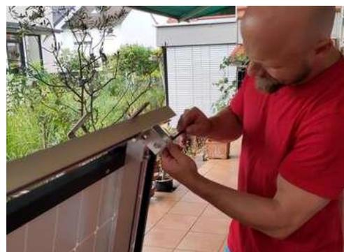
Abbildung 2: Verbinden von Gelenk und Modul
