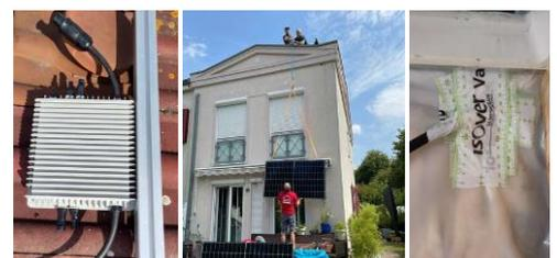
Abbildung 15: Wechselrichter montiert; Module auf das Dach! luftdichtes abkleben des Kabels
