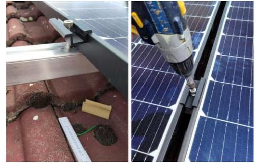
Abbildung 16: Befestigen der Module mit Modul-Mittelklemmen
