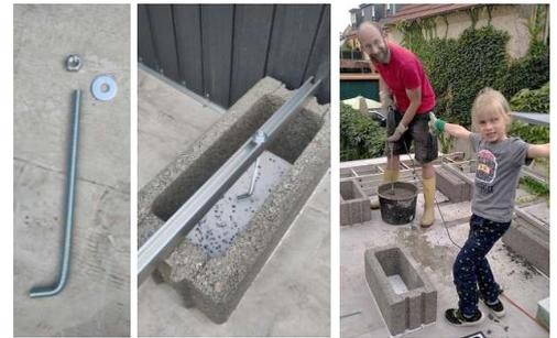
Abbildung 11: Abgewinkelte Gewindestangen, fertig zum Betonieren, bei der Arbeit
