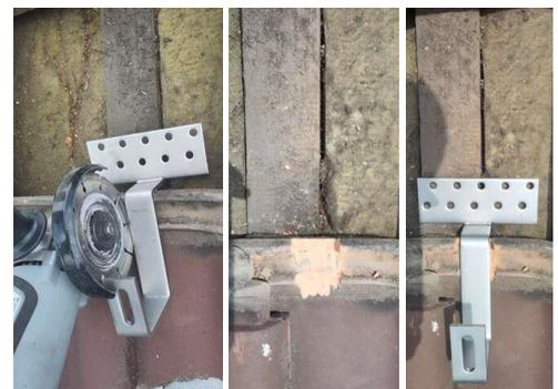
Abbildung 19: Die Profilierung der Ziegel wurde mit dem Winkelschleifer passgenau entfernt.
