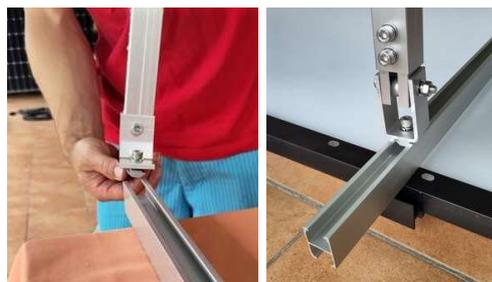
Abbildung 4: Montage der Teleskopstütze
