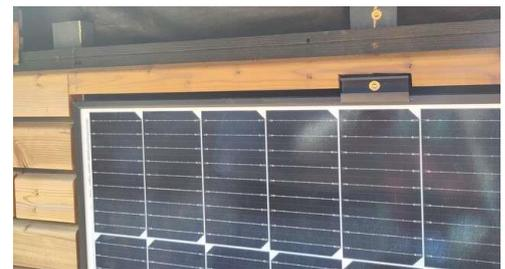
Abbildung 9: Verkleidung für Modulendklemmen ausklinken
