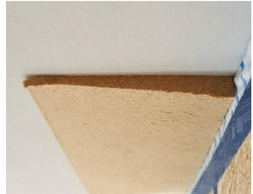
Abbildung 13: Gekaufter Dämmkeil aus Holzweichfaserplatten © Passivhaus Institut
