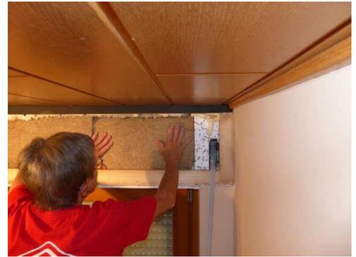
Abbildung 30: Dämmung eindrücken.
