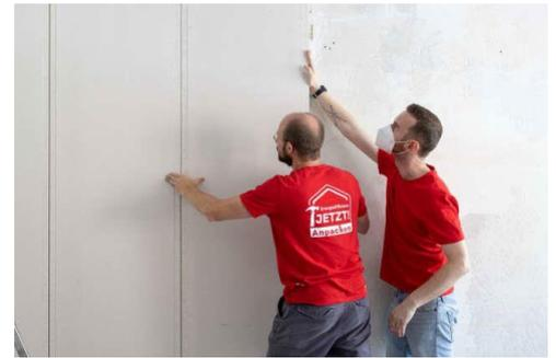
Abbildung 9: Beim Setzen der Dämmstoffplatten.
