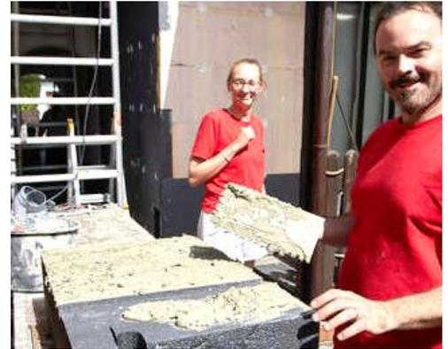
Abbildung 4: WDVS: Kleber aufbringen. © Passivhaus Institut
