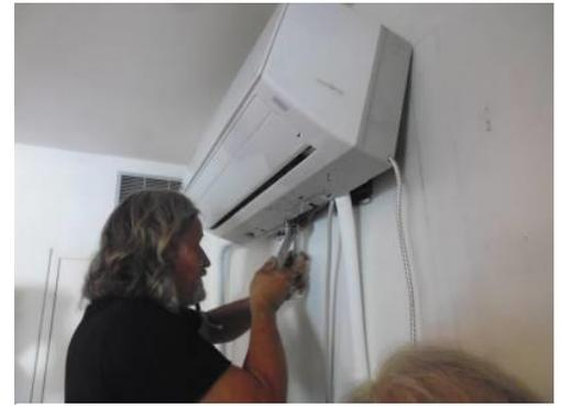
Abbildung 37: Montage der Inneneinheit eines Splitgerätes. © Passivhaus Institut
