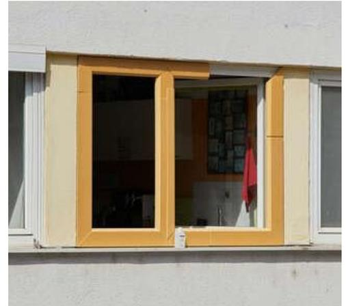
Abbildung 27: Profilierte Dämmschalen probenhalter eingesetzt. © Passivhaus Institut
