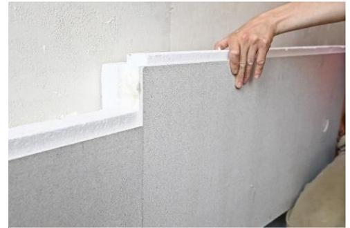
Abbildung 8: Ankleben der Dämmstoffplatten.
