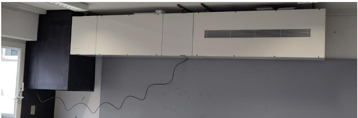
Abbildung 36: Lüftungsgerät und Luftkanal in fast fertigem Zustand, © Passivhaus Institut
