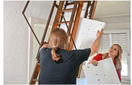
Abbildung 19: Anbringen der zugeschnittenen Dämmstoffplatten. © LEA-Hessen/Rundel
