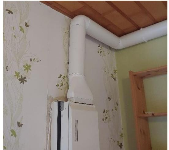
Abbildung 35: Das Lüftungsgerät ist an der Außenwand installiert, eine Abluftleitung führt die Luft aus dem Badezimmer zum Gerät. © Passivhaus Institut
