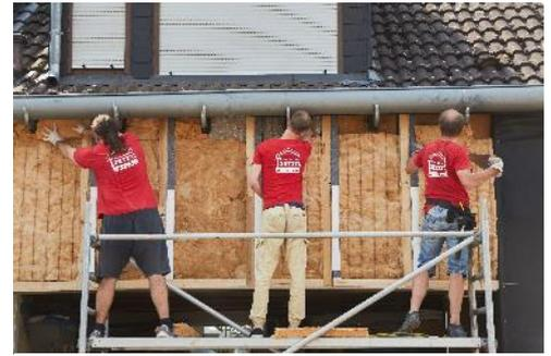
Abbildung 6: Einbringen des Dämmstoffes.
