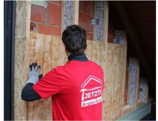
Abbildung 5: Eindrücken der Dämmstoffmatten.
