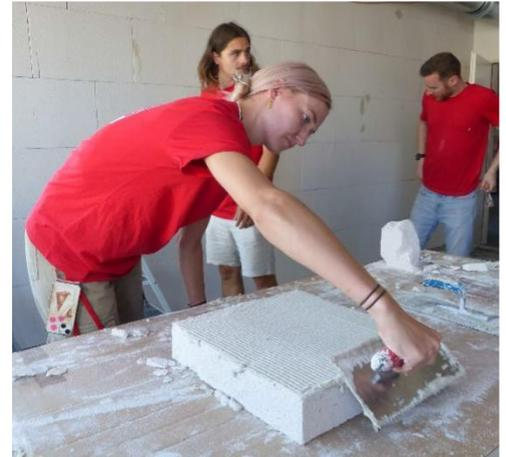
Abbildung 10: Mineralschaumplatten mit Kalkklee-
