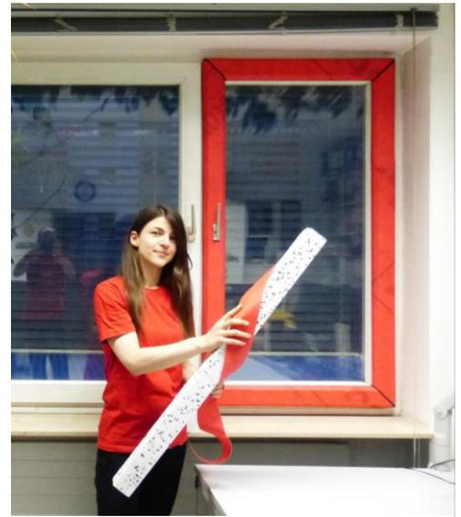
Abbildung 25: Der fertig gedämmte Fensterrahmen. © Passivhaus Institut
