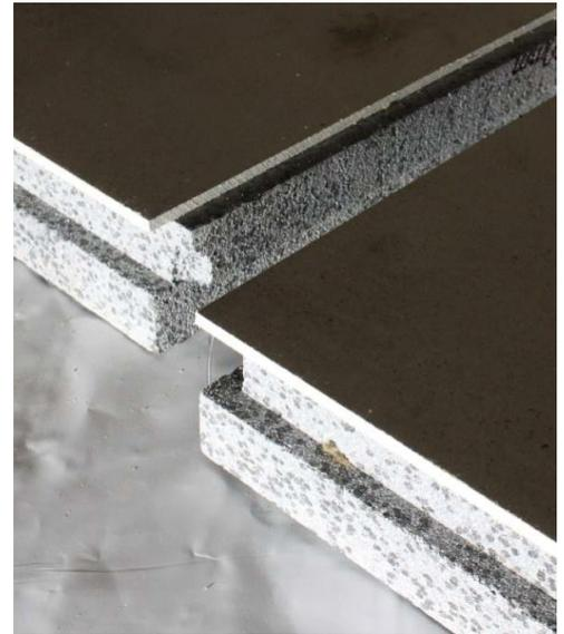
Abbildung 21: Begehbare Dämmstoffplatten mit Nut- und Federfalsz für die Dachdämmung. © PHI/Gocht
