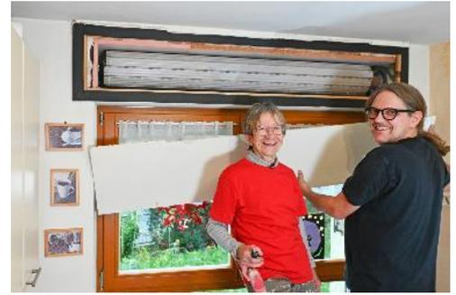
Abbildung 29: Verschließen des gedämmten Kastens. © LEA-Hessen/Rundel
