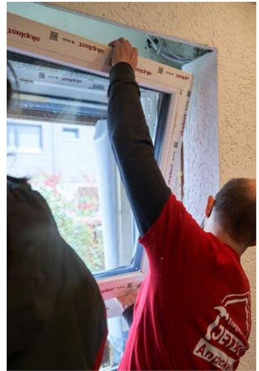
Abbildung 31: Einsetzen des neuen Fensterflügels. © Passivhaus Institut
