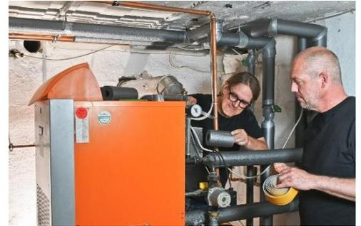
Abbildung 33: Dämmen warmer Rohrleitungen mit PE-Schalen. © LES-Hessen/Rundel
