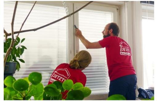
Abbildung 23: Aufgeklebte Isolierfolie andrücken.
