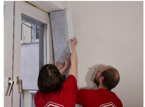
Abbildung 26: Einkleben der Fensterlaibungsdämmung. © Passivhaus Institut
