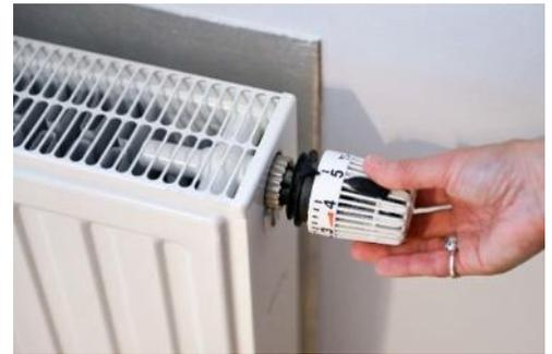
Abbildung 40: Das Herunterdrehen des Heizkörperthermostats, z.B. von 5 auf 2, bewirkt eine Temperaturreduktion und damit eine Energieeinsparung. © LEA-Hessen/Rundel
