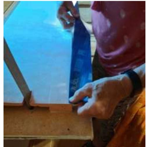
Abbildung 19: Die Dämmplatte ist an verschiedenen Stellen ausgeschnitten. Aufkleben eines Kantenschutzes.
