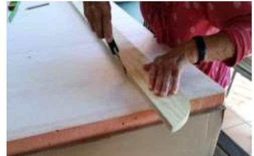
Abbildung 14: Platten beidseitig anschneiden...
