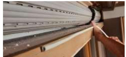
Abbildung 20: Luftdichtheitsband aufkleben.
