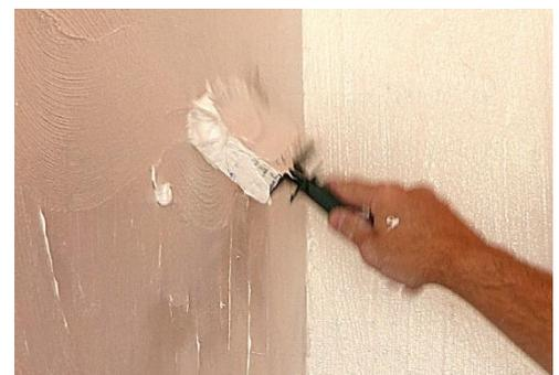
Abbildung 18: Aufbringen der luftdichten Schicht
