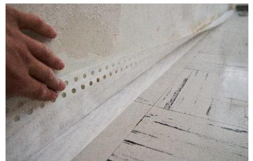
Abbildung 6: Luftdichte Verklebung der Fuge zwischen Mauerwerk und Estrich mit einem diffusionsoffenen Klebeband
