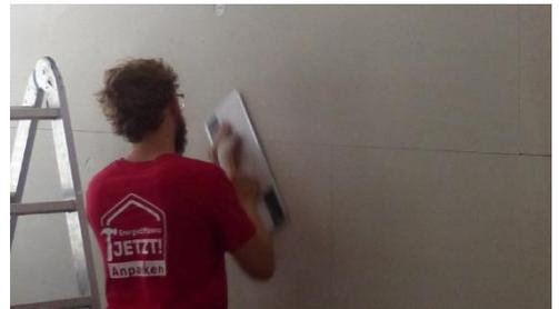
Abbildung 12: Abschleifen der neuen Wandoberfläche mit einem Schleifbrett
