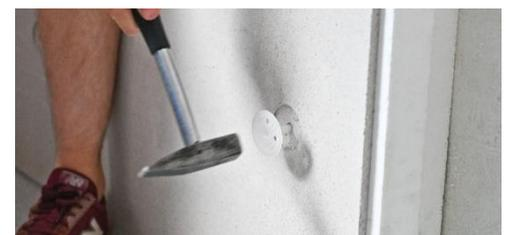
Abbildung 9: Anbringen der Platte und Einschlagen der Dübel
