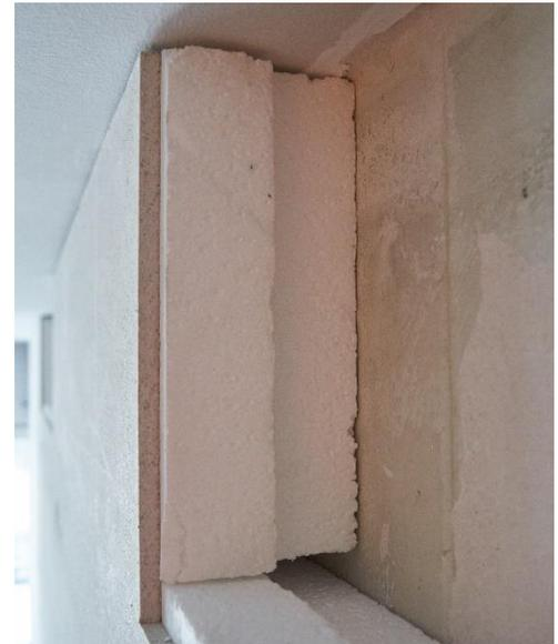
Abbildung 11: Abgeschnittener Stufenfalz bei der obersten Plattenreihe vor dem Verkleben
