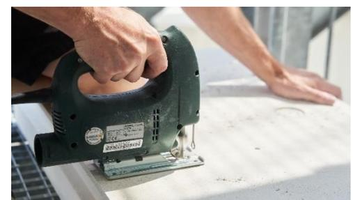
Abbildung 10: Schneiden der Verbundplatten
