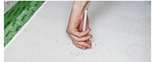
Abbildung 7: Herstellen der Vertiefung für die Dämmstoffteller
