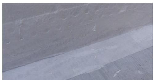
Abbildung 19: Verbindung luftdichter Verklebung mit der luftdichten Streichabdichtung
