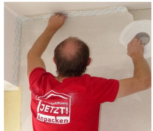
Abbildung 17: Luftdichte Verklebung zwischen neuer Wandoberfläche und alter Decken-, Boden- und Wandoberfläche
