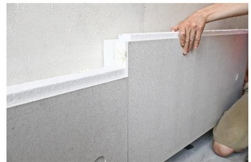
Abbildung 1: Innendämmung mit Verbundplatte aus Polystyrol- und Gipsfaserplatte
