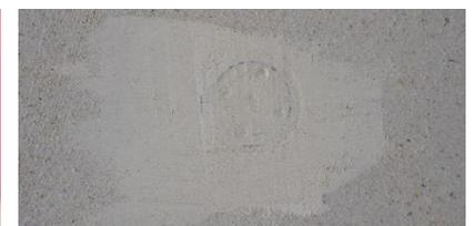
Abbildung 15: Bild vor und nach dem Verspachteln der Oberfläche
