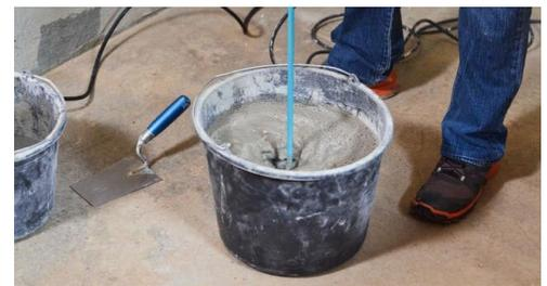
Abbildung 3: Anmischen des Klebemörtels
