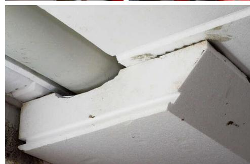
Abbildung 8: Leitungen mit einer weiteren Platte überdämmen
