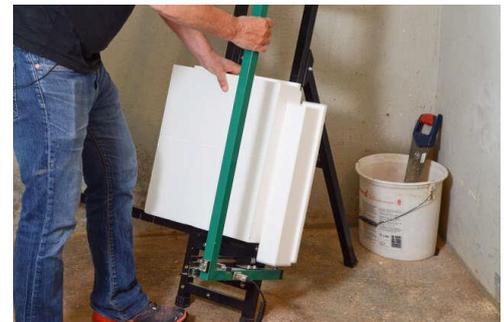
Abbildung 6: Schneiden der EPS-Platten mit einem Profi-Heißdrahtschneider
