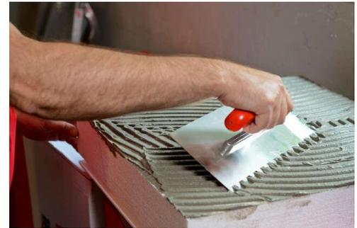
Abbildung 4: Auftragen des Klebemörtels
