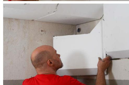
Abbildung 10: Flankendämmung anbringen.
