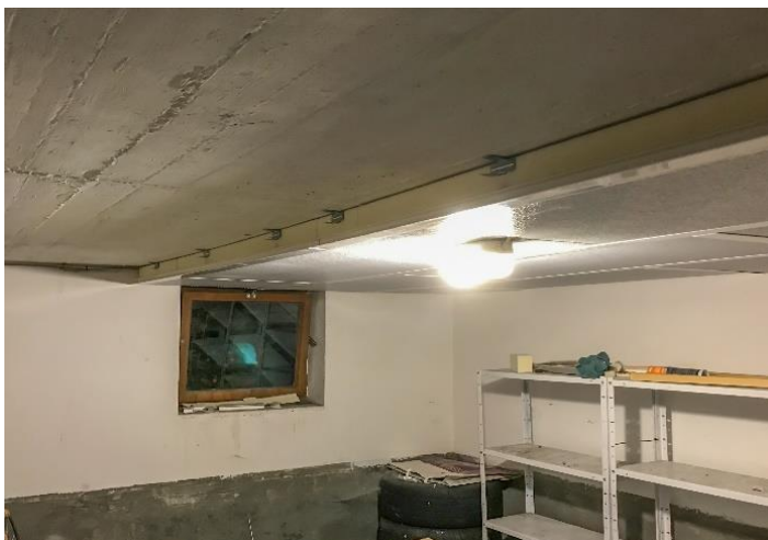
Abbildung 12: Wärmedämmung der Kellerdecke in Arbeit.
