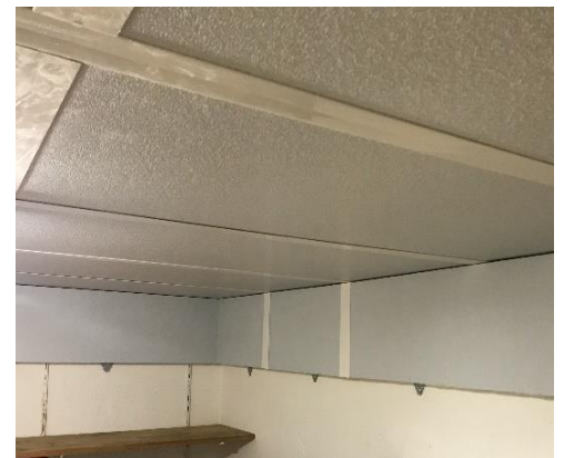
Abbildung 1: Kellerdeckendämmung und Flankendämmung aus alukaschierte Polyurethan-Hartschaumplatten
