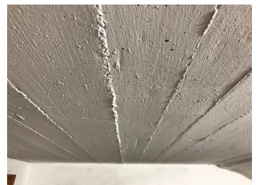
Abbildung 2: Betonkellerdecke mit Unebenheiten vor der Anbringung der Dämmung
