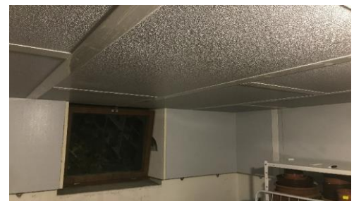
Abbildung 13: Fertig mit Flanken- und Laibungsdämmung.
