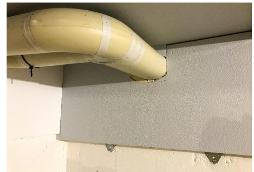
Abbildung 11: Flankendämmung an durchdringender Warmwasser-Leitung
