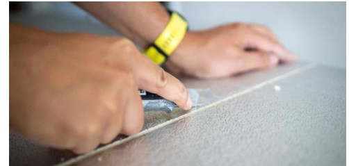
Abbildung 9: Schneiden einer Nut für ein Stromkabel.
