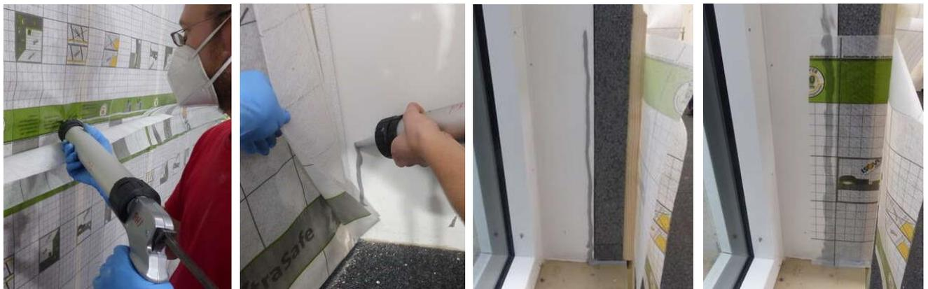
Abbildung 18: Bahnen untereinander, an den Wänden, Decken und in den Fensterleibungen sorgfältig verkleben und andrücken
