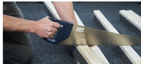
Abbildung 6: Verbundträger mit der Handsäge schneiden...
