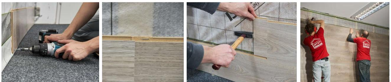
Abbildung 21: Die erste Reihe zusätzlich zur Klammer in der Feder mit einer Schraube sichern. Lücken zwischen den Paneelen mit einem Schlagholz und einem Hammer schließen (ohne Schlagholz wird die Feder zerstört)
