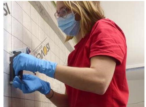
Abbildung 19: Membrane antackern. Eine 1,5 m breite Bahn wird etwa die Hälfte der Wand überdecken
