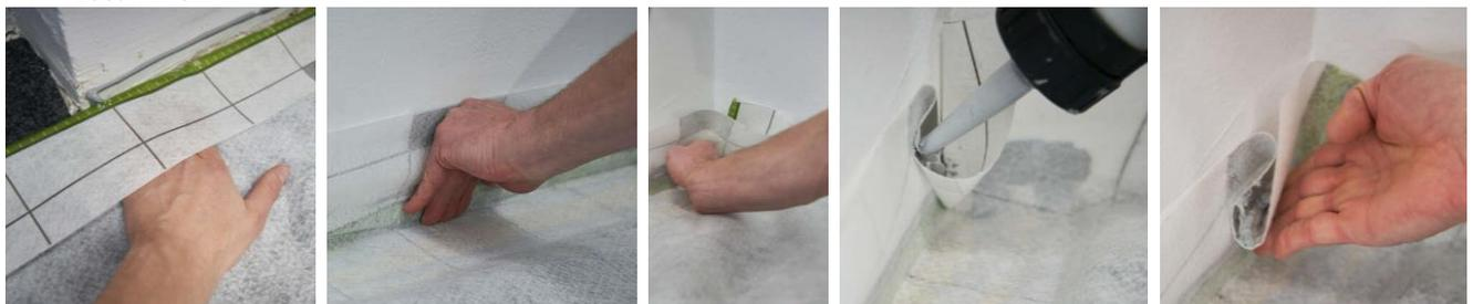
Abbildung 12: Sorgfältig am Boden, an der Wand und in den Ecken andrücken. Die in der Ecke entstehende Falte wird in sich verklebt.
