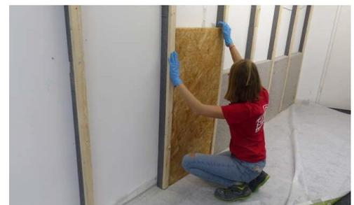
Abbildung 16: Dämmstoffmatte einklemmen
