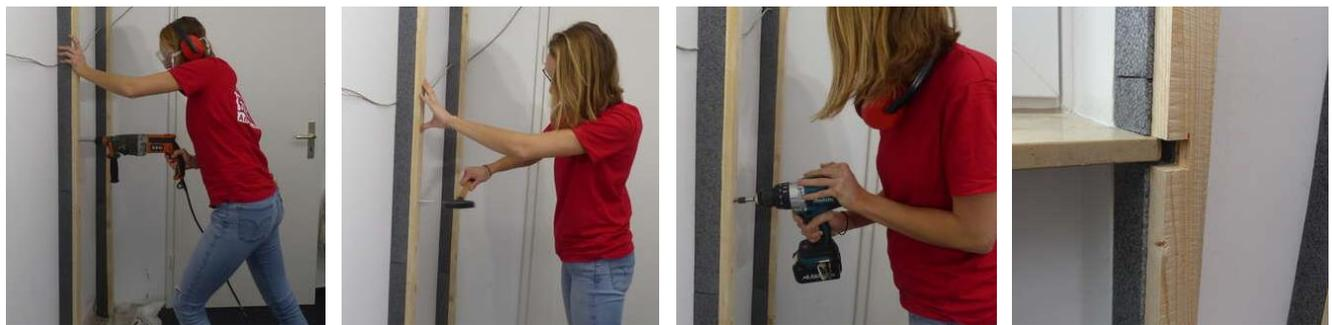
Abbildung 15: Löcher bohren, Rahmendübel einschlagen und Schraube eindrehen. Die Träger z. B. an Fensterbänken ausklinken.
