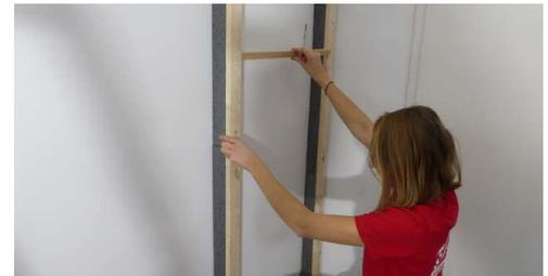
Abbildung 14: Abstände zwischen den Trägern z. B. mit einem Distanzholz justieren
