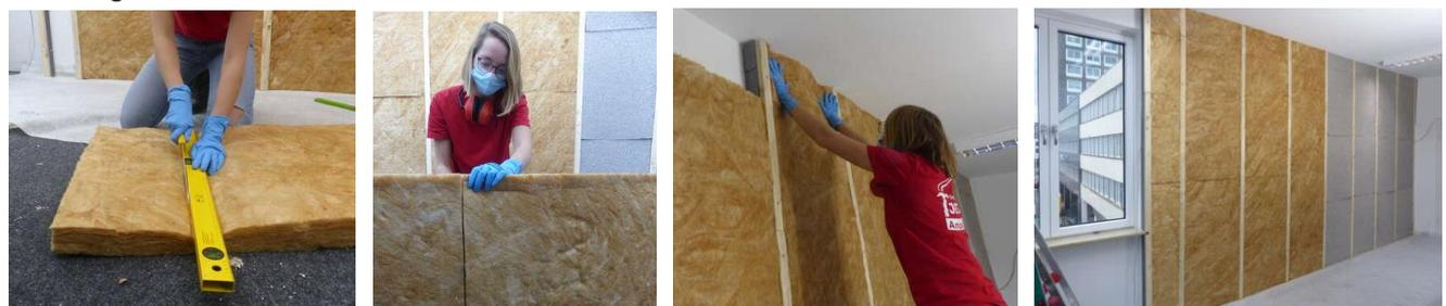
Abbildung 17: Dämmung wo nötig schneiden und einpassen. Fertig gedämmte Wand. Links Mineralfaser-, rechts Zellulosematten
