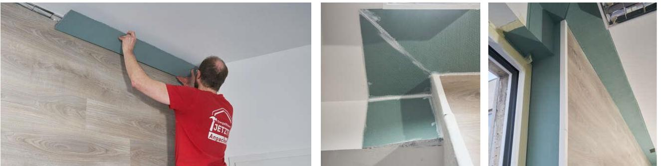
Abbildung 24: Keile anbringen, mit Acryl verfugen und überstreichen – fertig!
