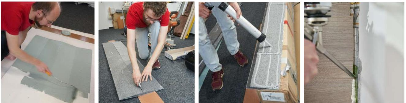
Abbildung 23: Keile streichen, schneiden, Dichtkleberrapun ziehen, Lücken mit PU-Schaum füllen
