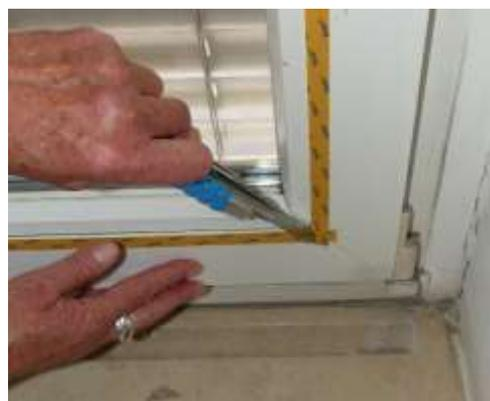
Abbildung 4: Überlappende doppelseitige Klebestreifen durchschneiden.
