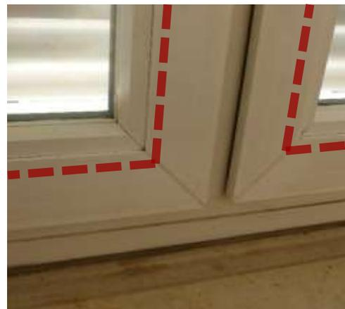
Abbildung 3: Fensterrahmenecke nach dem Säubern. Am besten, du klebst das doppelseitige Klebeband an den markierten Stellen auf.
