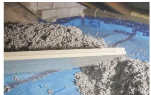
Abbildung 1: Aufgelockerte Zellulose an Ort und Stelle schieben. © Passivhaus Institut
