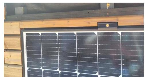
Abbildung 23: Verkleidung für Modulendklemmen ausklinken
