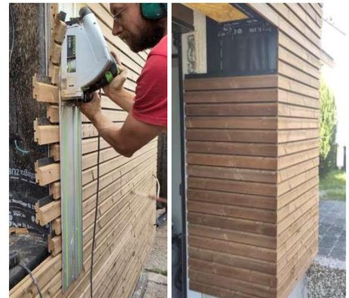
Abbildung 21: Präzises Abschneiden überstehender Bretter mit Tauchsäge und Führungsschiene (links). Mit Gehrungsschnitten gebildete Ecke.
