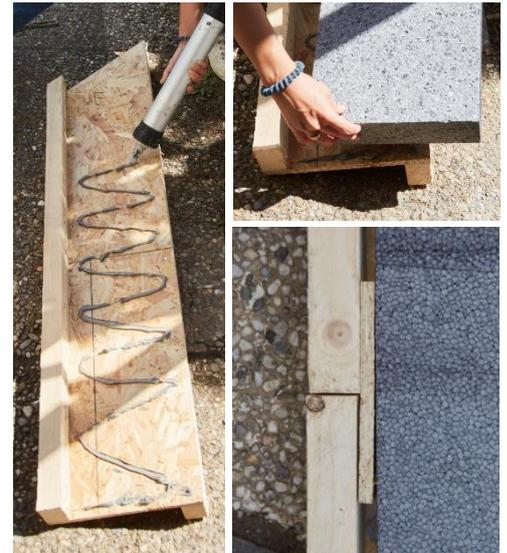
Abbildung 12: Aufbringen des Klebers (links), aufkleben des EPS (oben). Unten: Verstärkter Gurt-Stoß. EPS dort noch ausschneiden.
