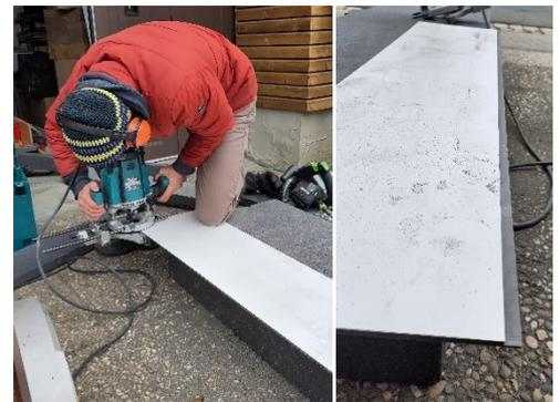
Abbildung 34: oben: Dünnerfräsen der Fensterbank; unten: Test mit einem Reststück.
