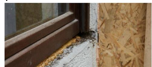
Abbildung 28: oben: Schnittzeichnung des seitlichen Fensteranschlusses; unten: Z-Träger angebracht, Fensterbank entfernt.
