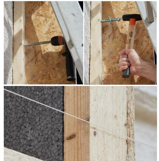
Abbildung 13: Bohren der Löcher (links), einschlagen der Bolzenanker (rechts). Spannen der Schnüre (unten).
