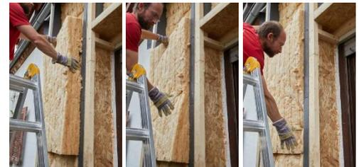
Abbildung 16: oben: Schneiden der Dämmung. unten: Eindrücken der Dämmung.
