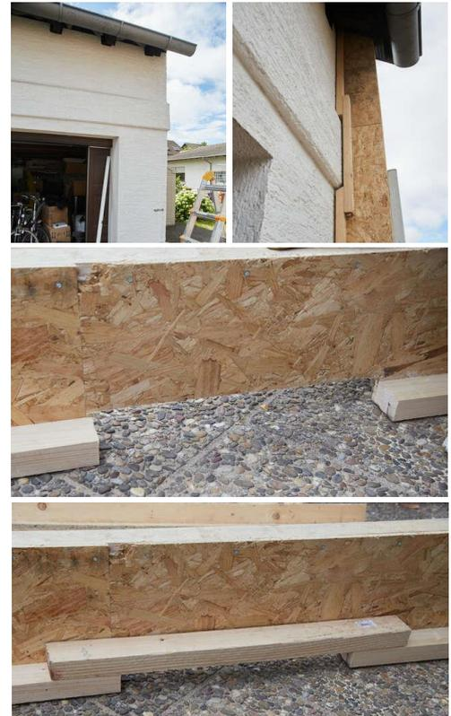
Abbildung 27: oben links: vorspringendes Garagendach; oben rechts: modifizierter Träger; Mitte: ausgesparter Träger; unten: ausgesparter Träger mit versetztem Gurt.
