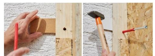
Abbildung 14: Unterfüttern der Träger im Bereich von Dellen.
