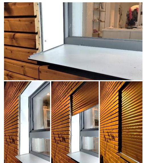
Abbildung 37: oben: Laibungsplatte befestigt; unten: Fertige Fensterläubung mit geöffnetem, halb- und ganz geschlossenem Rollladen.
