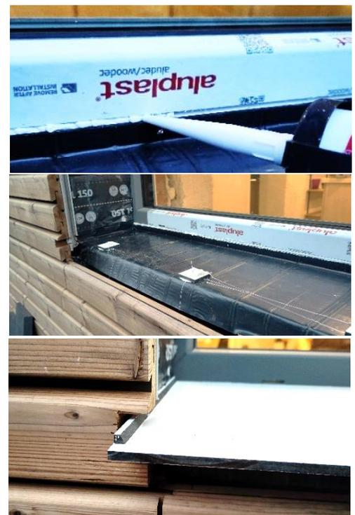
Abbildung 36: links: Füllen der Nut mit Silikon; Mitte: Distanzklötze aufgeklebt; rechts: Fensterbank mit Leisten eingesetzt
