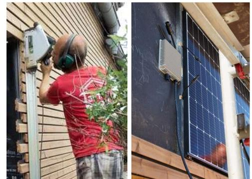
Abbildung 22: Fassadenverkleidung absägen; Wechselrichter und Modul montieren
