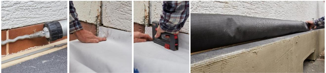
Abbildung 8: Von links nach rechts: Dichtkleberraupe aufbringen, Winddichtungsmembrane eindrücken und antackern, Membrane aufrollen.
