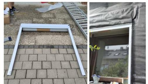
Abbildung 32: links: Rollladenschiene und Rollladenkasten zusammengesteckt; rechts: eingebaut.
