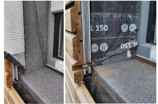
Abbildung 33: links: Leibungs- und Fensterbankdämmung eingeklebt; rechts: Fassade für die Fensterbank ausgeschnitten
