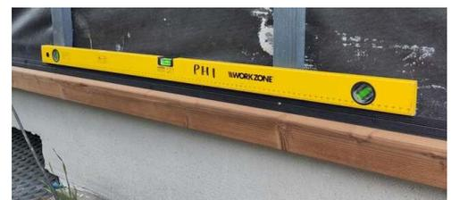
Abbildung 19: Sorgfältiges Ausrichten der ersten Lage mit der Wasserwaage
