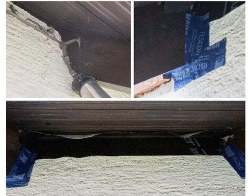
Abbildung 9: Andichten von Putz und Sparren an die Membrane zum späteren Anschluss der luftdichten Ebene des Daches
