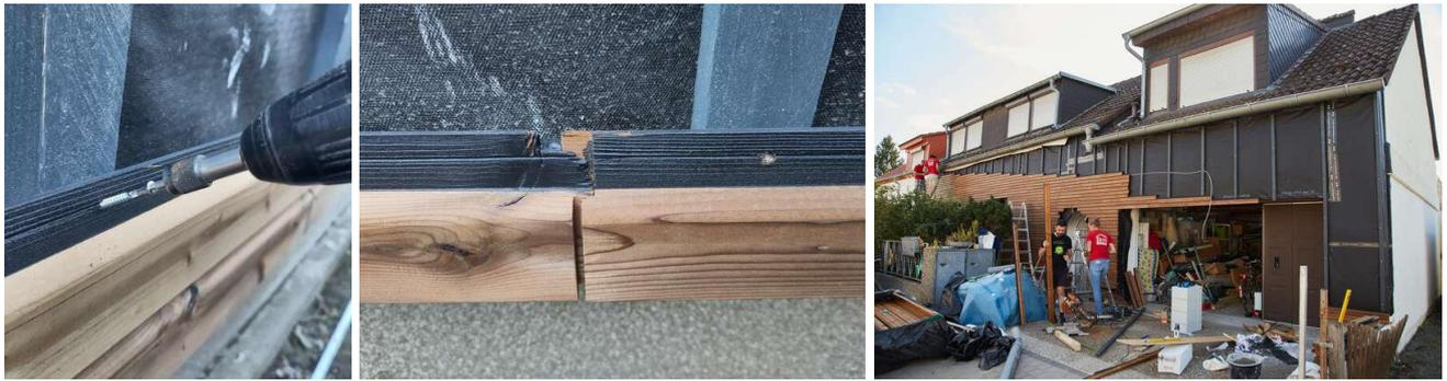
Abbildung 20: links: Schräges Einbohren der Schrauben in die Schraubnut; Mitte: Stoß im Feld rechts: Die Fassade entwickelt sich von links nach rechts.
