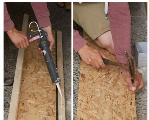
Abbildung 11: Aufbringen des Klebers (links) und Einschlagen der Ankeranker (rechts)
