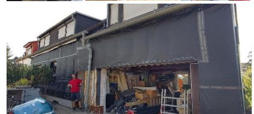
Abbildung 18: Oben: Antackern der Membrane. Unten: Vorläufig gegenfest.
