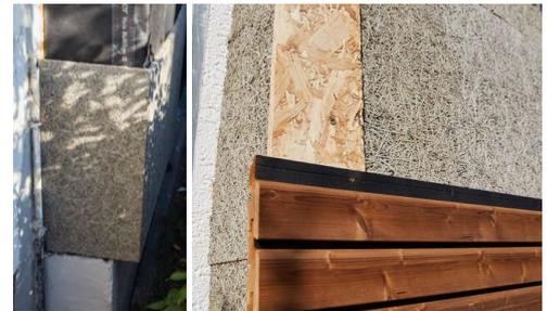
Abbildung 25: Über Eck angebrachte Holzwolle-Leichtbauplatte mit und ohne Verkleidung
