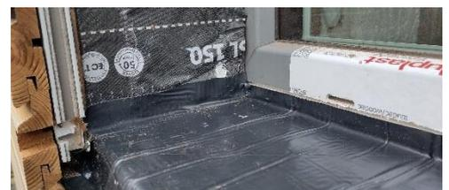
Abbildung 35: Als Wanne ausgebildetes Bitumenklebeband.
