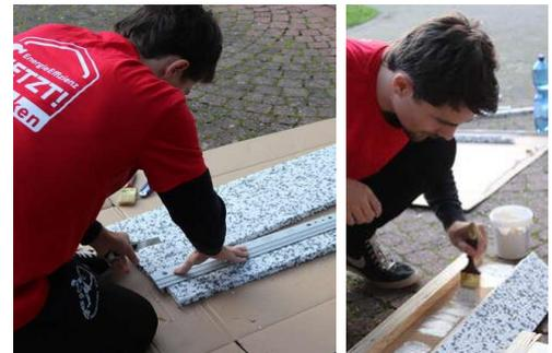
Abbildung 5: Zuschneiden und einkleben der EPS-Dämmung in die Stegträger
