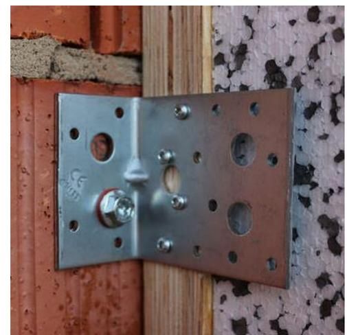
Abbildung 6: Stegträger und Winkel verschraubt
