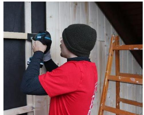
Abbildung 10: Montieren der Schalung
