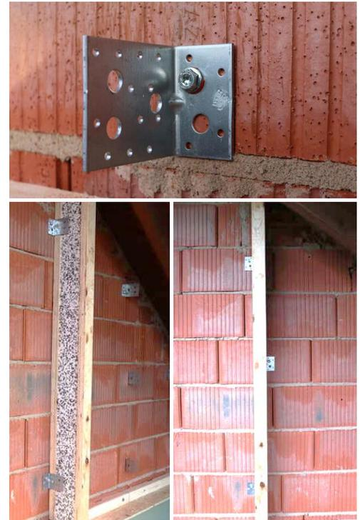
Abbildung 4: Angedübelter Winkel (oben). Die Winkel werden rechts und links der Stegträger angedübelt (unten)
