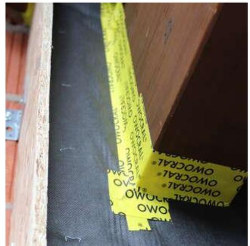
Abbildung 8: Verlegen und abkleben der Unterspannbahn
