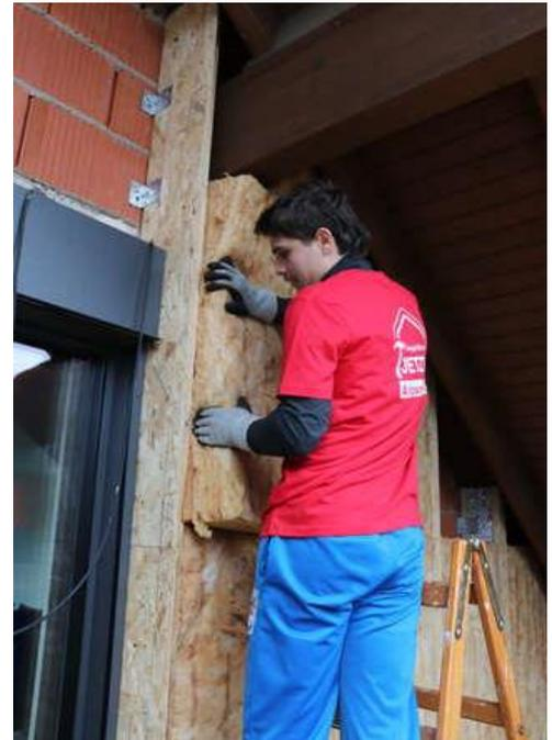
Abbildung 7: Einklemmen der Dämmung
