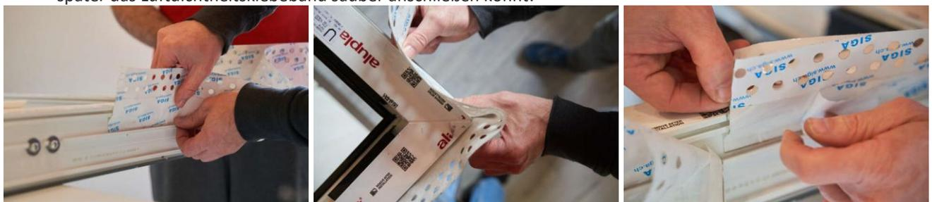
Abbildung 10: Die eine Seite des Luftdichtheitsklebebandes ist umgefaltet, die Schutzabdeckung ist mehrfach geteilt. Zieht die Schutzabdeckung von der kürzeren Seite des Bandes ab, und klebt das Band unter den Rahmen (links). An den Rahmenecken bildet ihr eine Lasche aus (Mitte). Die Stoßstellen des Bandes lasst ihr überlappen und klebt sie dann aufeinander (rechts).
