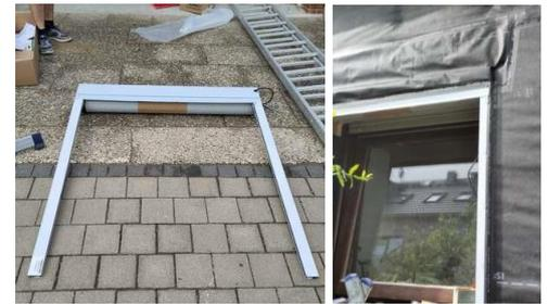
Abbildung 15: links: Rollladenschienen und Rollladenkasten zusammengesteckt; rechts: eingebaut.
