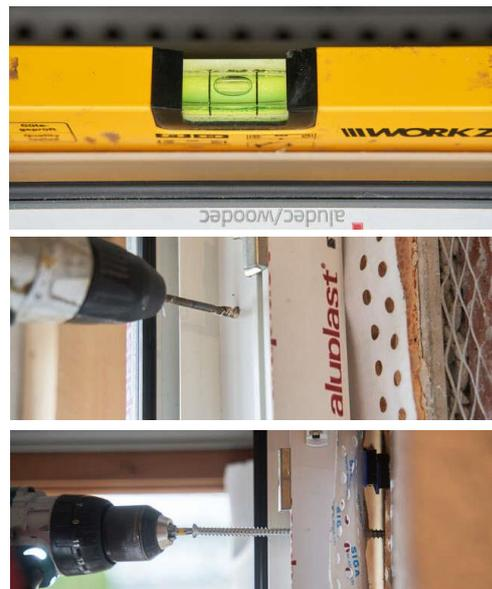
Abbildung 11: Nivellieren des Fensters (oben). Vorbohren (hier in Holz) (Mitte). Festschrauben, (rechts oben im Bild die Nivellierkeile) (unten).
