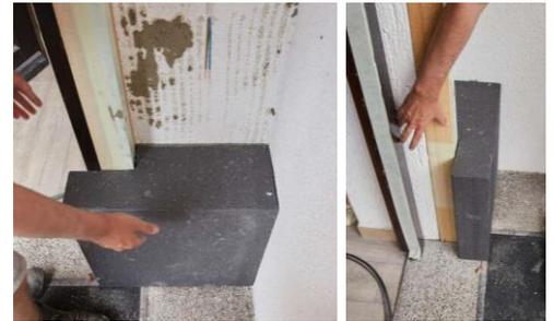
Abbildung 21: Zugeschnittene Dämmstoffplatte aus unterschiedlichen Blickwinkeln.
