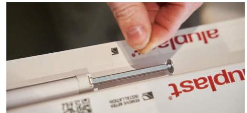
Abbildung 7: Entfernen des Metallstifts am oberen Fensterbeschlag.
