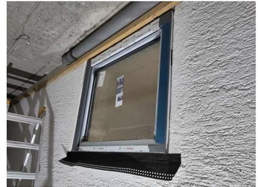
Abbildung 24: Altes Fenster ausgebaut (oben). Neues Fenster eingebaut, winddichte Ebene unten hergestellt (Seiten folgen noch) (unten).
