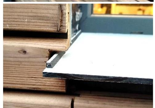
Abbildung 18: oben: Füllen der Nut mit Silikon; Mitte: Distanzklötze aufgeklebt; unten: Fensterbank mit Leisten eingesetzt
