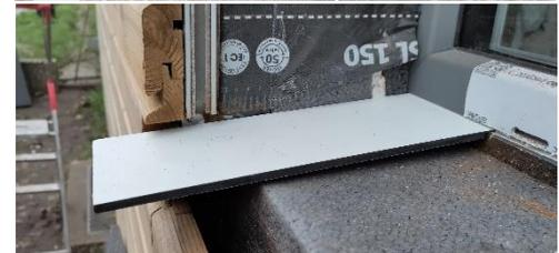
Abbildung 17: oben: Dünnerfräsen der Fensterbank; unten: Test mit einem Reststück.
