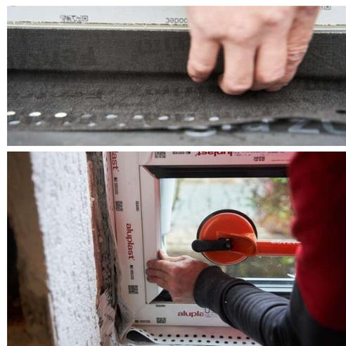
Abbildung 12: Aufkleben der winddichten Ebene mit „Dehnungsschlaufe“ (oben). Festverglasung und Glashalteleisten einsetzen (unten)
