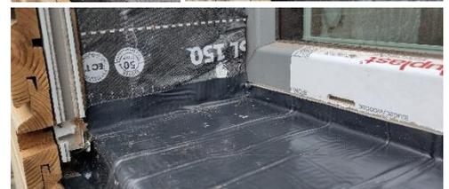
Abbildung 16: Links: Leibungs- und Fensterbankdämmung eingeklebt. Rechts: Fassade für die Fensterbank ausgeschnitten. Unten: Als Wanne ausgebildetes Bitumenklebeband.
