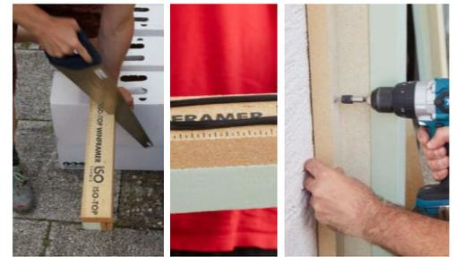
Abbildung 20: Zusägen, Kleberauren auf dem Montagerahmen, anschrauben.
