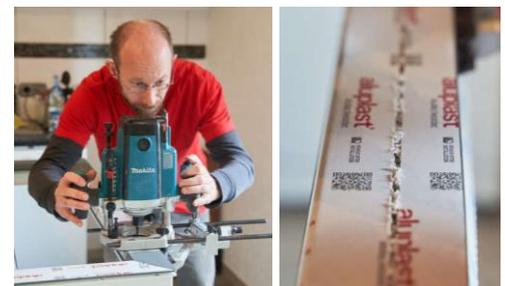
Abbildung 9: Auffräsen des Rahmens (links) und Ergebnis (rechts).
