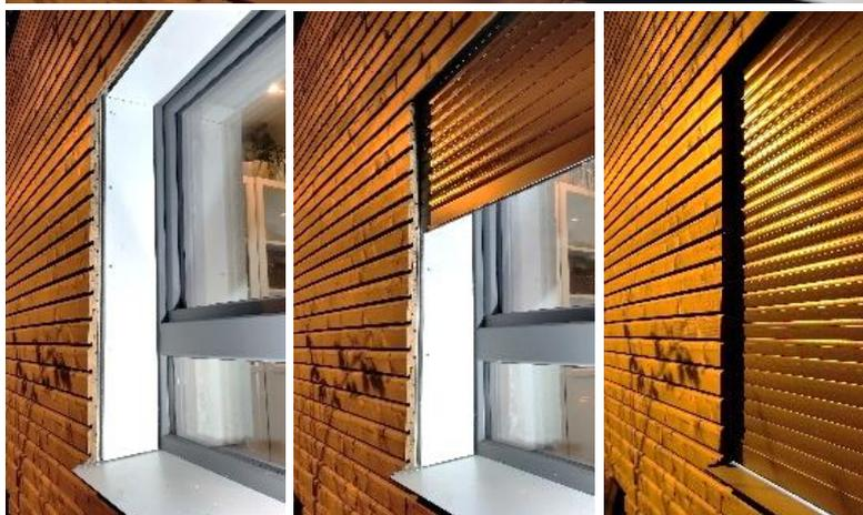
Abbildung 19: oben: Laibungsplatte befestigt; unten: Fertige Fensterlaibung mit geöffnetem, halb- und ganz geschlossenem Rollladen.
