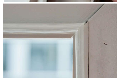
Abbildung 17: Schlauchdichtung wird auf den Kunststoffwinkel geklebt (oben), Unten: Die Schlauchdichtungen stoßen an den Ecken zusammen.
