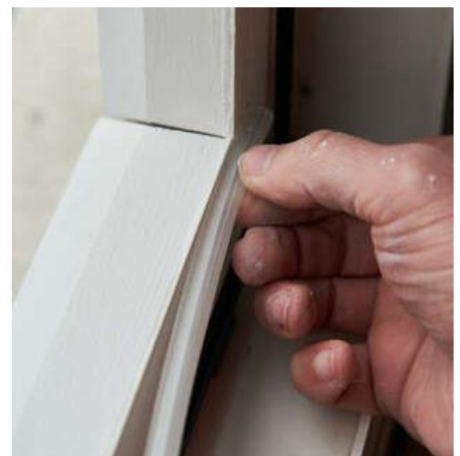
Abbildung 16: Eindrücken des PVC-Winkels.
