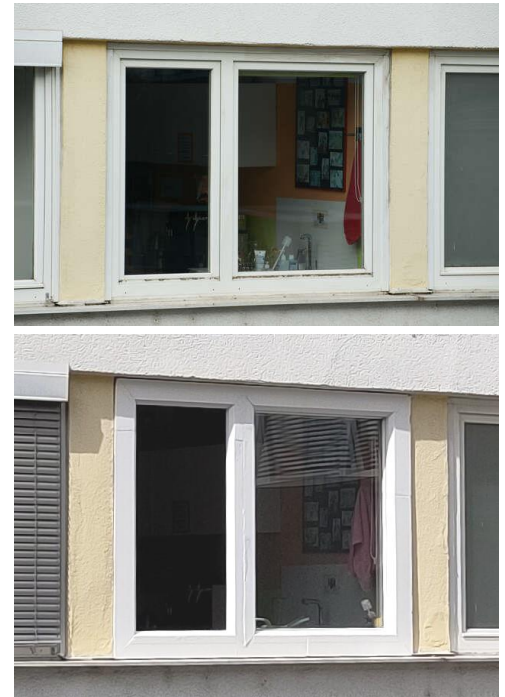
Abbildung 1: Fenster vor- und nach der Maßnahme.
