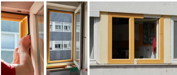
Abbildung 8: Teste, ob die zugeschnittenen Profile auf die Fenster passen. Fixiere die Profile provisorisch mit doppelseitigem Klebeband.
