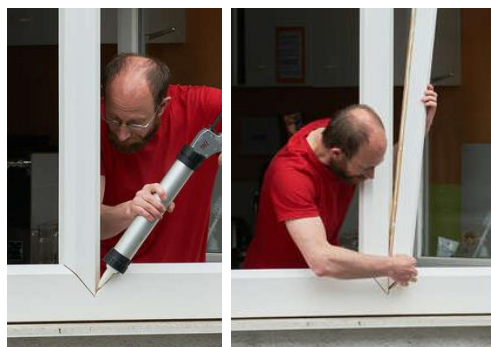
Abbildung 14: Auch die beiden Pfostenschalen werden eingesetzt und sorgfältig verklebt.
