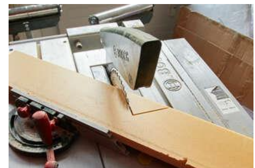
Abbildung 7: Ausschneiden der Ecken für die Dämmschalen der Pfosten.
