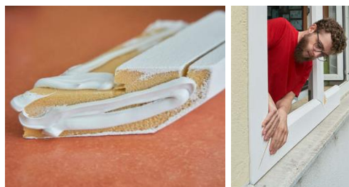
Abbildung 13: Bringe auch auf die Stirnseiten der Profile satt Montagekleber auf und drücke die einzelnen zusammen. Herausquellenden Kleber wischst du bitte sofort ab.
