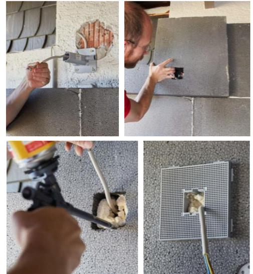
Abbildung 30: Fuß des angedübelten Geräteträgers (oben links). Angepasste Dämmstoffplatte wird aufgeklebt (oben rechts). Hohlraum mit PU-Ortschaum verfüllt (unten links). Montageplatte aufgesteckt und gesichert (unten rechts).
