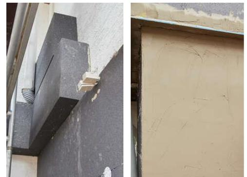
Abbildung 23: Dicke und dünne Dämmung aufgeklebt (links). Erste Putzlage unten fertig und Eckschutzwinkel eingearbeitet (rechts)
