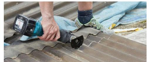
Abbildung 27: Kürzen der Acrylplatten
