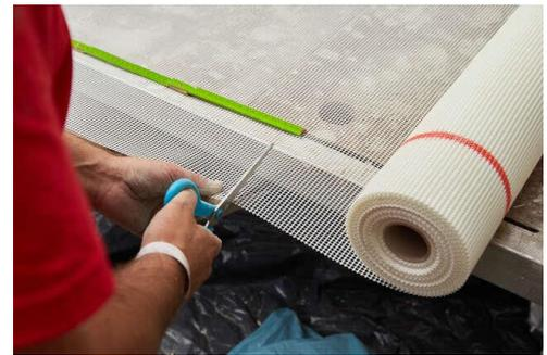
Abbildung 13: Armierungsgewebe zuschneiden
