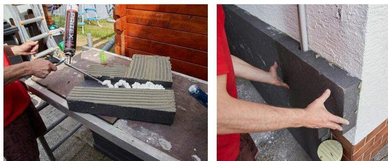
Abbildung 21: Füllen der Aussparung mit Bauschaum und ankleben der Platte
