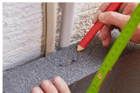
Abbildung 19: Anzeichnen der Aussparung
