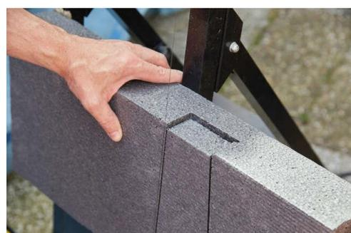
Abbildung 20: Aussparungen mit dem Heißdrahtschneider herstellen.
