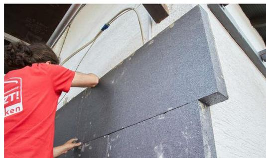
Abbildung 7: An der Ecke jede zweite Platte zum Verzahnen in Plattendicke überstehen lassen
