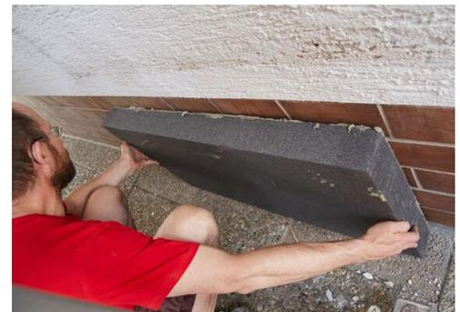
Abbildung 5: Setzen der der ersten Platte
