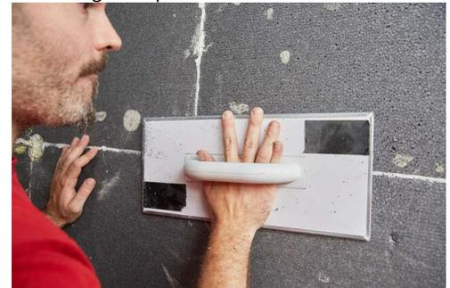
Abbildung 10: Glätten von Ecken und Kanten mit dem Schleifbrett
