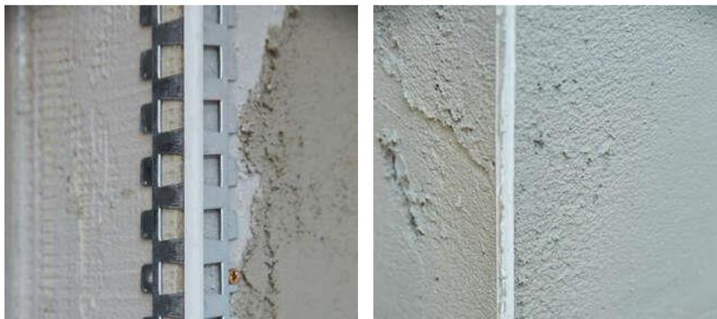
Abbildung 16: Einbetten der Eckschutzwinkel
