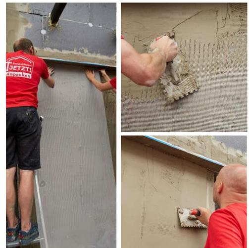
Abbildung 14: Einarbeiten der Putzarmierung
