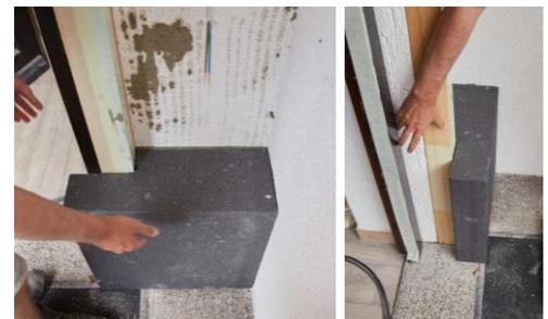
Abbildung 34: zugeschnittene Dämmstoffplatte aus zwei unterschiedlichen Blickwinkeln. Zwischen den Türrahmen und die überstehende Dämmstoffplatte kommt noch der Dämmstoffstreifen (E in Abb. 32), der mit dem neuen Fenster entfernt wird.
