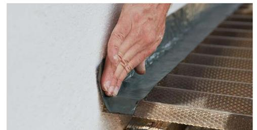
Abbildung 28: Andichten der Acrylplatten
