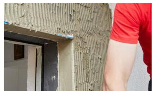
Abbildung 35: Türrahmen (links), Dämmstoffstreifen (E), noch unverputzt (Mitte) und Fassadendämmung schon mit der 1. Lage verputzt (rechts).
