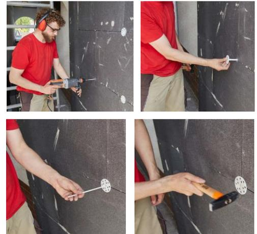
Abbildung 8: Dübelloch bohren, Dübel einsetzen, Einschlagbolzen aus Kunststoff setzen und einschlagen
