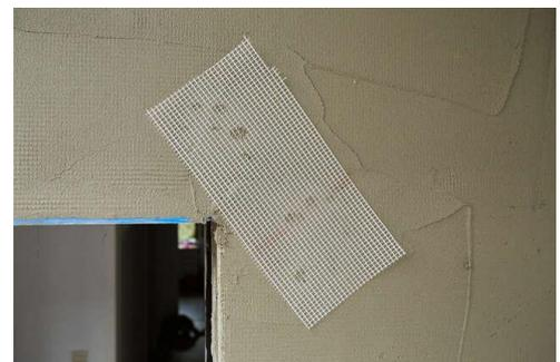
Abbildung 15: Rissarmierung über den Ecken der Fensteröffnungen
