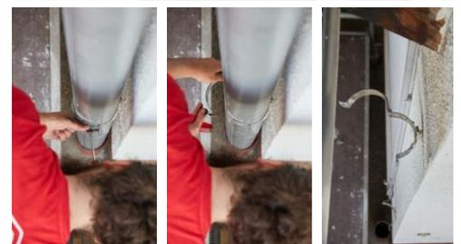
Abbildung 2: Abbau des Vordaches und der Regenfallrohre.
