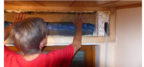
Abbildung 6: Lücken ausgeschäumt.
