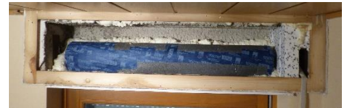
Abbildung 6: Lücken ausgeschäumt.
