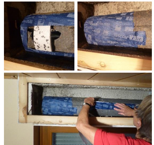
Abbildung 4: Abdichtung des Fraßloches und der Stoßstellen des Gehäuses mit Luftdichtheitsklebeband.
