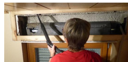
Abbildung 3: Säubern des Kastens mit dem Staubsauger. Links ist das Loch zu sehen, welches die Wespen gefressen haben.
