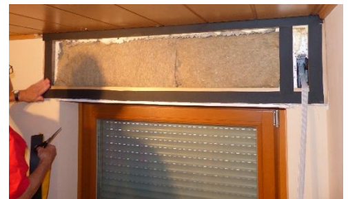
Abbildung 8: Isolierklebeband angebracht.
