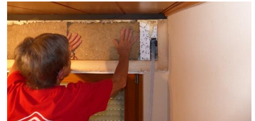
Abbildung 7: Dämmstoffmatten einbringen.
