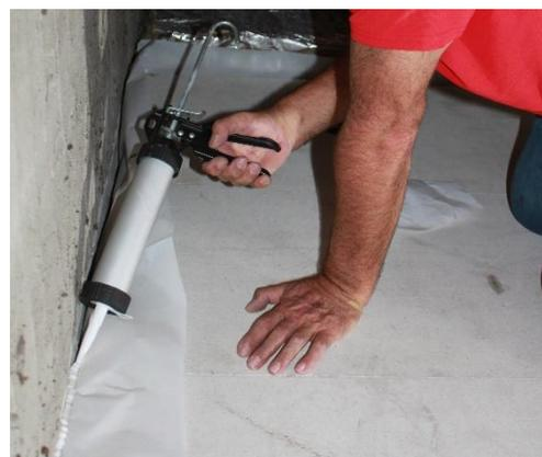
Abbildung 5: Aufbringen der Dichtkleberraupe in der Ecke zwischen Wand und Folie
