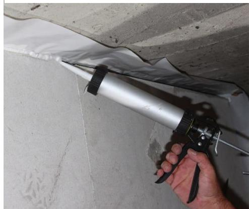
Abbildung 7: Schließen der Fuge mit Dichtkleber oder PU-Schaum
