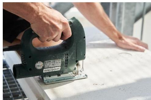
Abbildung 4: Schneiden des Dachboden-Dämmelements mit der Stichsäge
